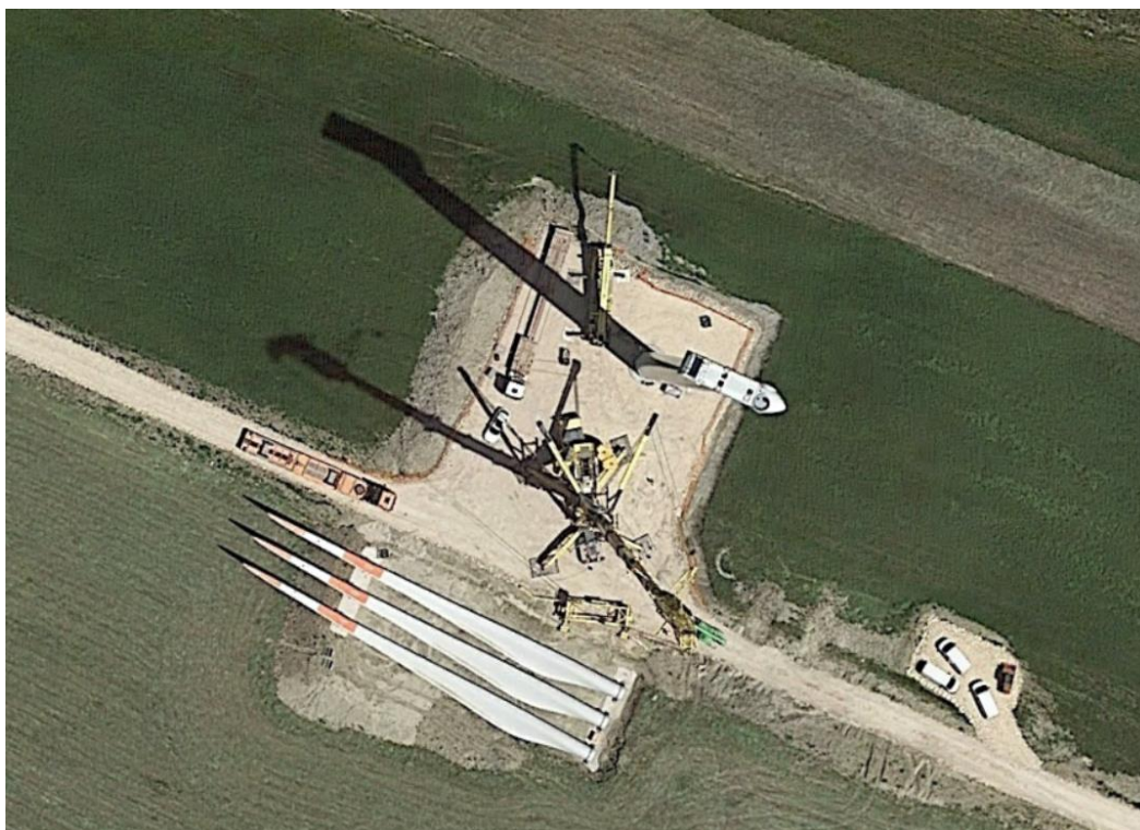
Figura 2.5 – esempio di piazzola in fase di costruzione
