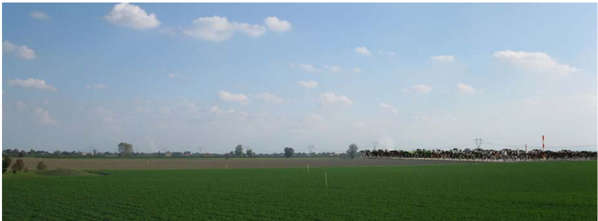
Figura 5.23: Centrale – Fase 1 di Esercizio (Vista 1)
