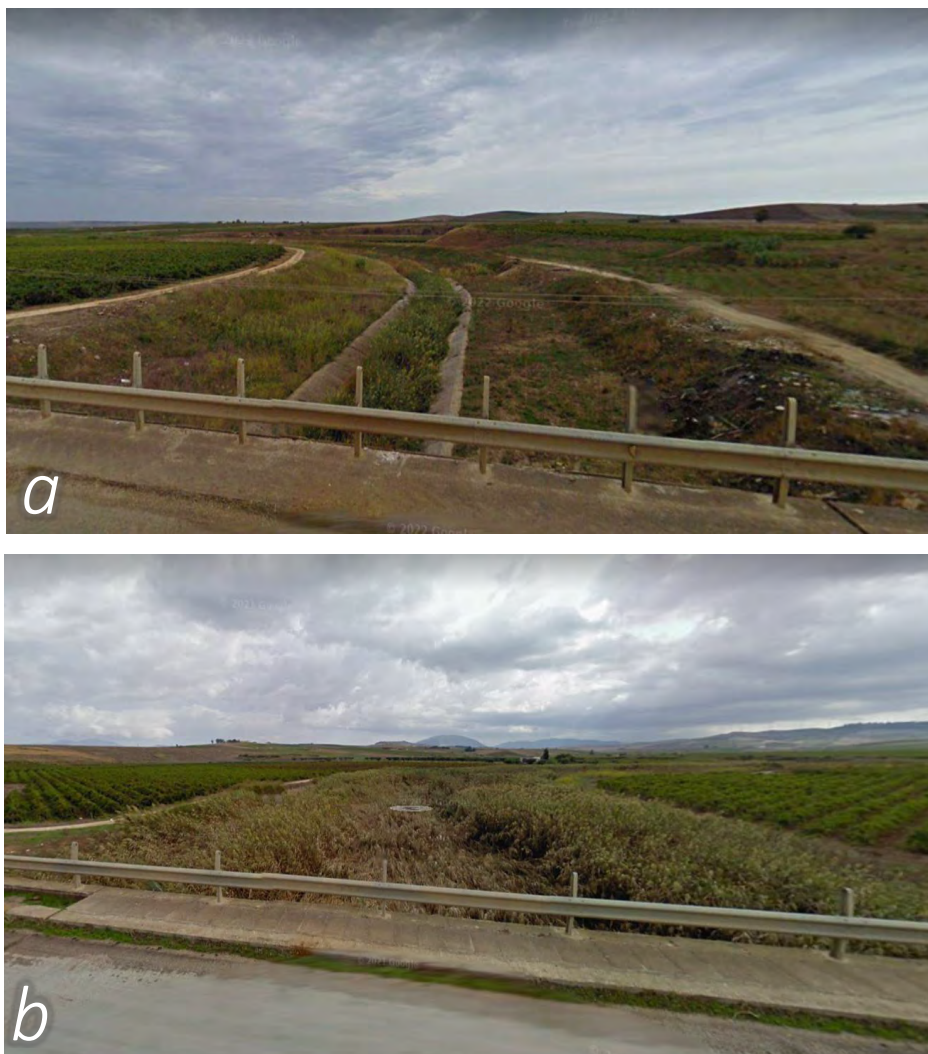
Figura 6.61: Punti di attraversamento del cavidotto lungo i fiumi Di Bordino (a) e Della Cuddia (b).
