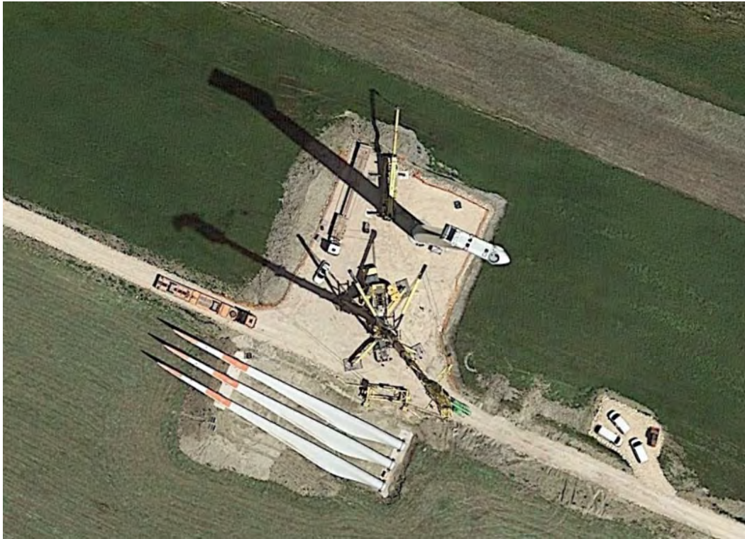
Figura 4.11: Esempio di piazzola in fase di costruzione
