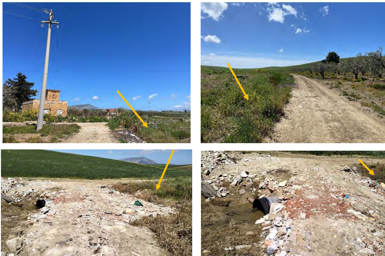
Figura 6.58: Foto di sopralluogo di tratti del corso d'acqua attraversato dalla pista della PAC03. Le frecce indicano la vegetazione spondale.
