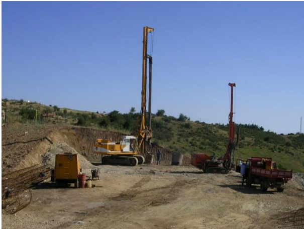
Realizzazione pali trivellati
