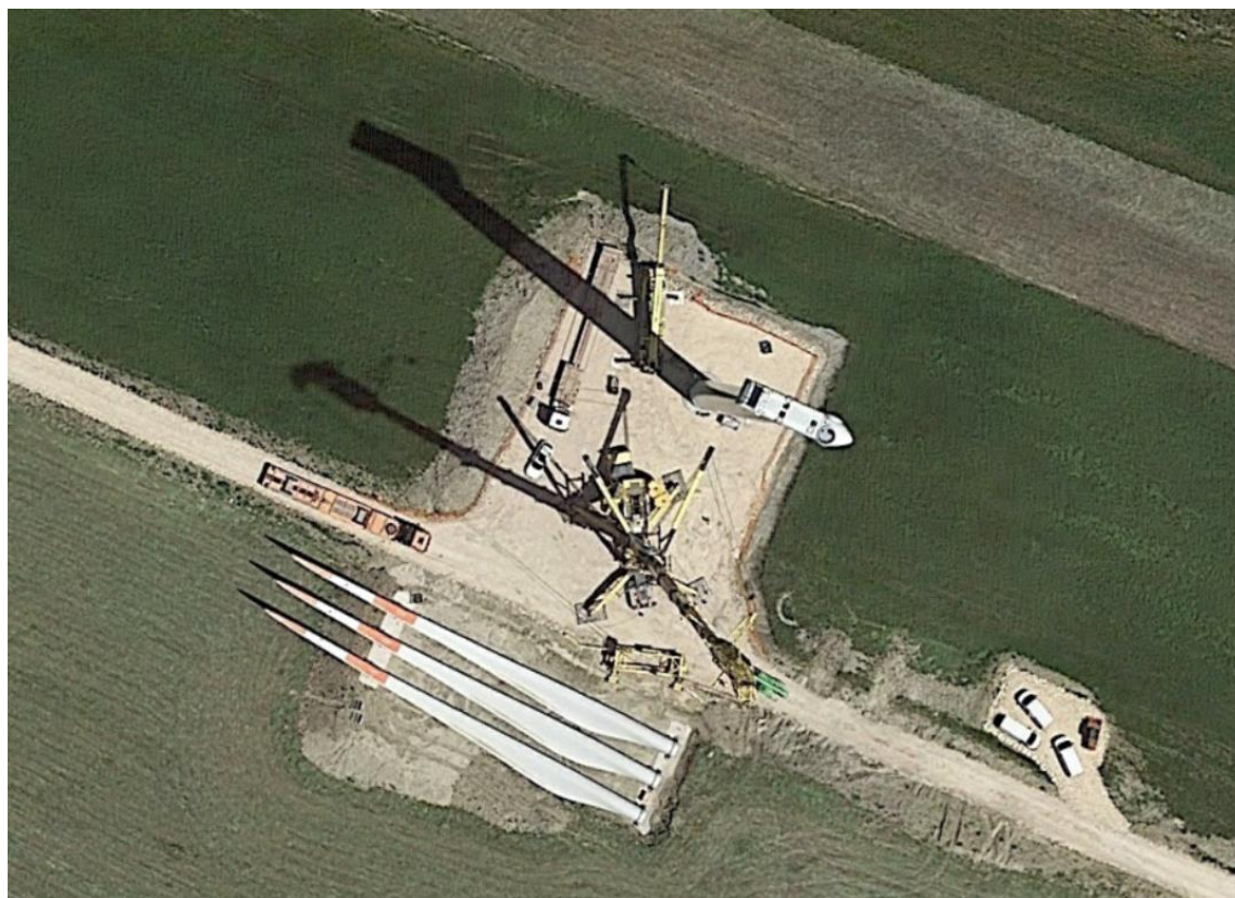
Figura 4.4: Esempio di piazzola in fase di costruzione
