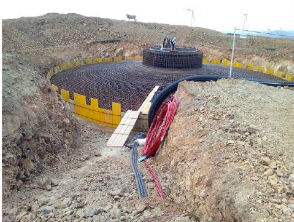
Posa ferri e cassetatura
