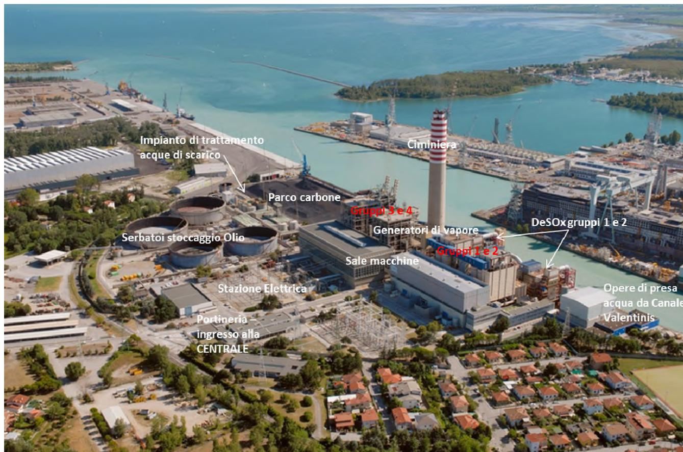
Figura 2.2.5 - 1 - Centrale termoelettrica di Monfalcone
