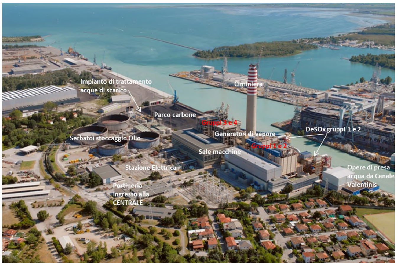
Figura 2.2.5 - 1 - Centrale termoelettrica di Monfalcone
