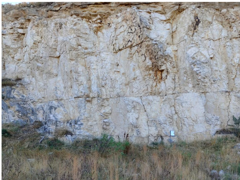
Fig. 3.6 – Sistemi di fratture e giunti di strato nel Calcare di Altamura su una parete di ex cava in loc. Masseria del Duchino a NO di Matera (pressi di Contrada S. Lucia) nei pressi del tracciato A, vista frontale (fronte interessato da rilievo geo-strutturale)
