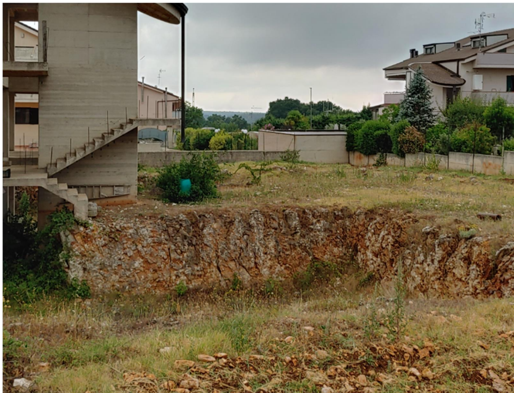
Fig. 5.5 . Alterazione del Calcarea di Altamura affiorante in corrispondenza di uno scavo, in loc. Iazzitello nei pressi del tracciato A lungo la variante di Santeramo in Colle
