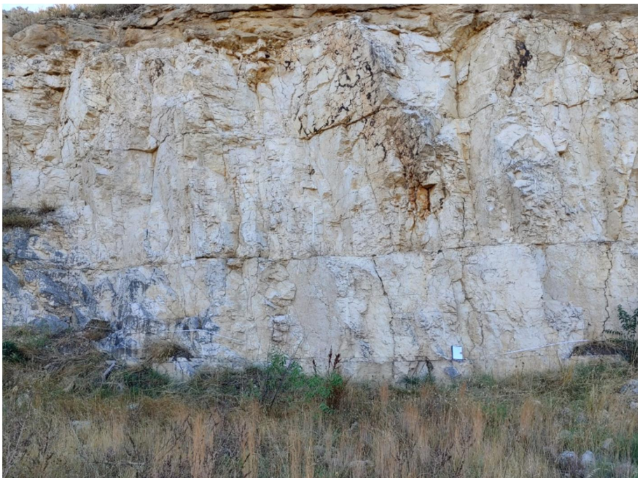
Fig. 5.15 . Sistemi di fratture e giunti di strato nel Calcarea di Altamura su una parete di ex cava in loc. Masseria del Duchino a NO di Matera (pressi di Contrada S. Lucia), nei pressi del tracciato A, vista frontale (fronte interessato da rilievo geo-strutturale)
