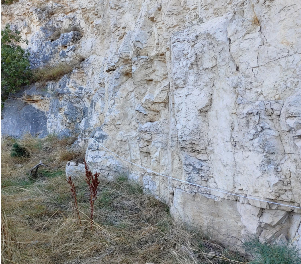
Fig. 5.16 . Sistemi di fratture e giunti di strato nel Calcarea di Altamura su una parete di ex cava in loc. Masseria del Duchino a NO di Matera (pressi di Contrada S. Lucia) nei pressi del tracciato A, vista laterale (fronte interessato da rilievo geo-strutturale)
