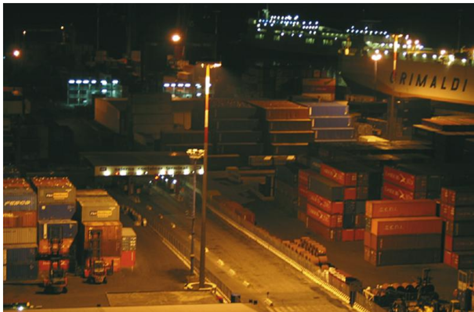
Torre faro con cono d'apertura inferiore ai 180°
