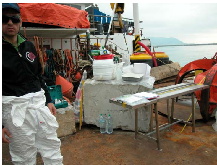
Figura 4 - Area cantiere/laboratorio allestita sul Motopontone "Sirio I".
