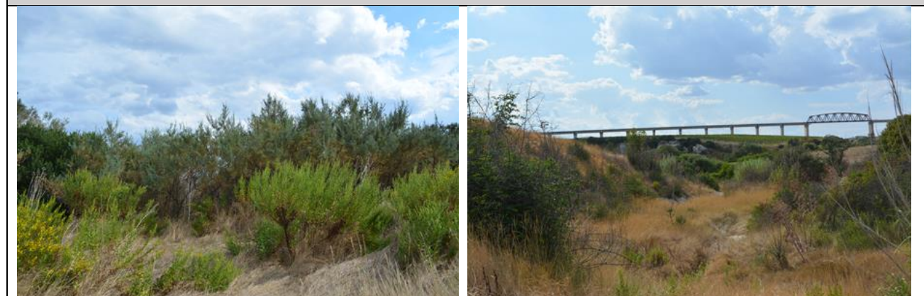
VEG17: Aspetto delle aree di rilievo della vegetazione ripariale e dell'alveo verso la gravina di Picciano
