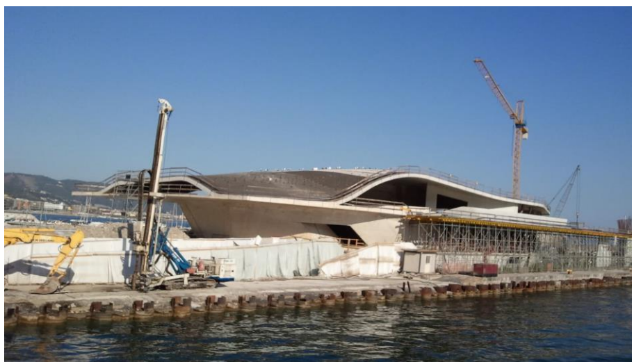
Figura 2-6 Stazione marittima: stato dei lavori
