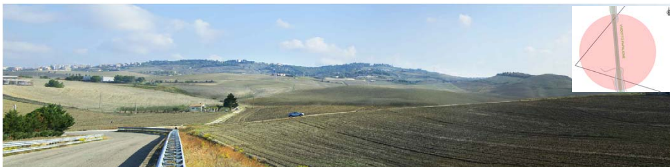
Figura 0-33 Viadotto Papalione– Ante operam
