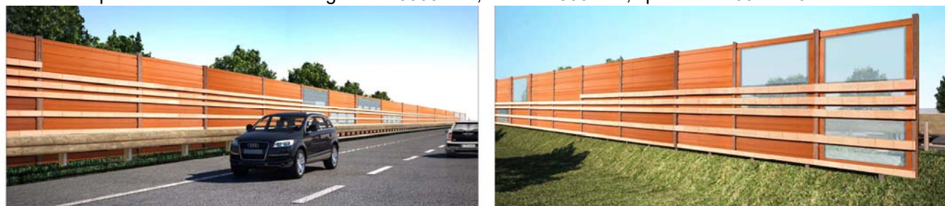
Figura 0-36 Ipotesi di realizzazione per le barriere fonoassorbenti
