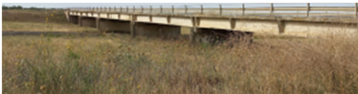
Foto 3 Ponte sul Canale Riu Nou
