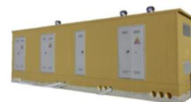
Essa ha la funzione di “raccolgere” le linee in AT in arrivo dalle 20 aree in cui è stato suddiviso l’impianto fotovoltaico dal punto di vista elettrico più quelle in arrivo dal sistema di storage posto nelle immediate vicinanze della cabina stessa. Ciascuna di queste aree contiene una Cabina di Area al cui interno è contenuto il trasformatore BT/AT che eleva la tensione di 800 V ac uscente dagli inverter ad un livello di 36 kV, superiore e ben più adatto per il trasporto dell’energia.
