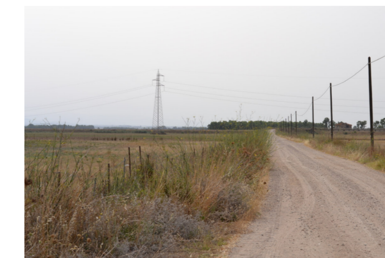
Foto 18 - END: progressiva 3.382 m.
