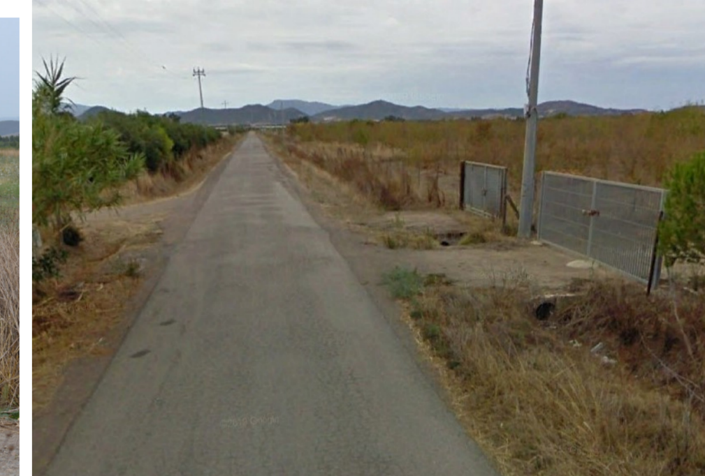
Foto 4 - Accesso dx alla progressiva 578 m.
