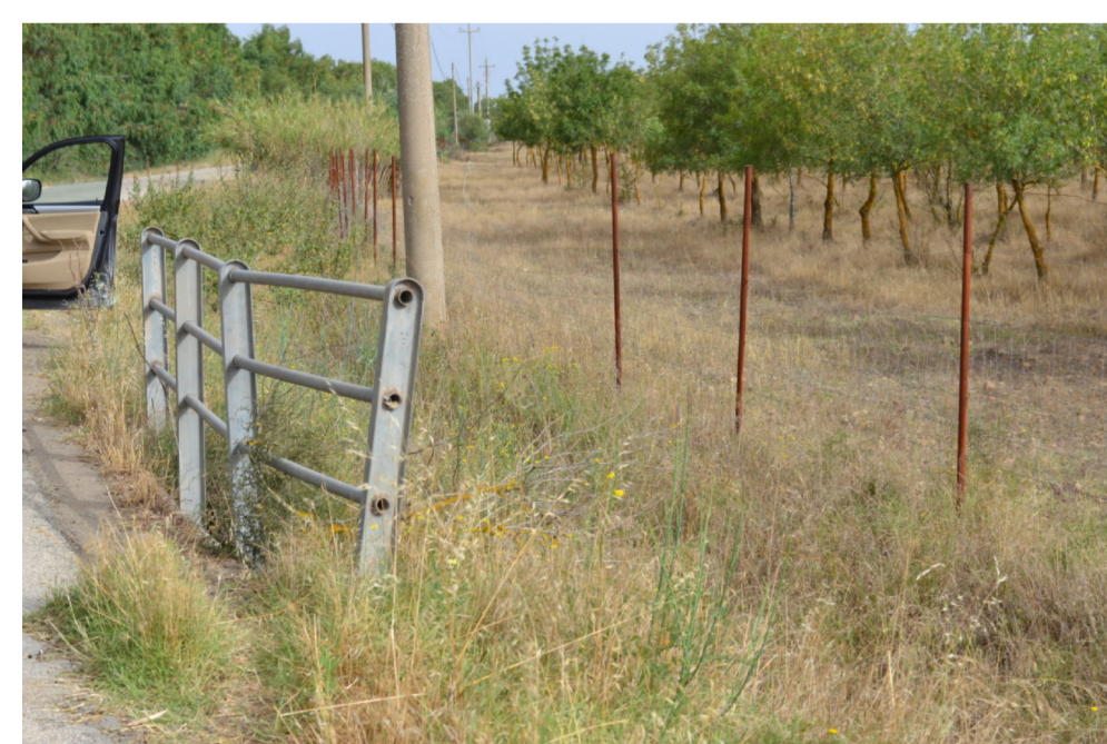
Foto 11 - Canale alla progressiva 1.431 m.
