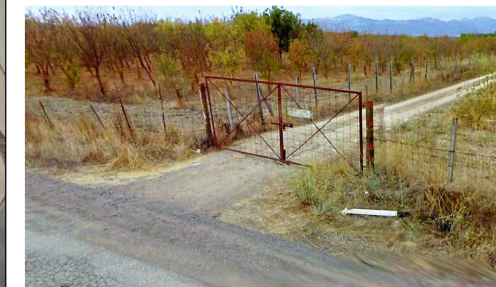
Foto 5 - Accesso dx alla progressiva 760 m.
