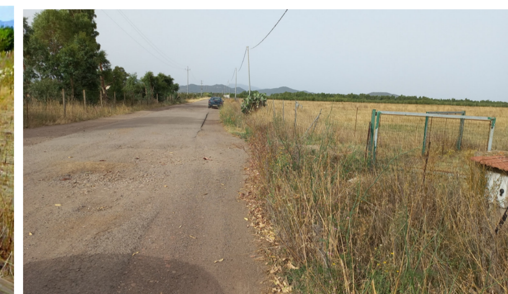
Foto 6 - Accesso dx alla progressiva 868 m.
