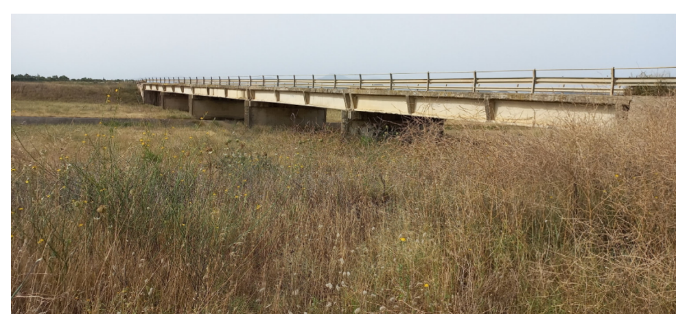
Foto 15a - Ponte alla progressiva 2.754 m.
