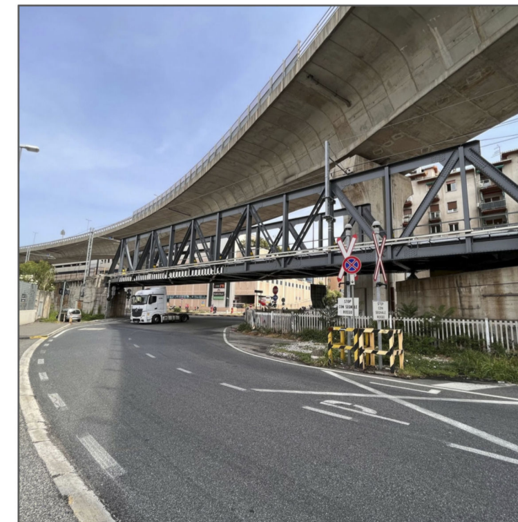
8 Via Italo Svevo - Via Federico Seismit Doda ponte ferroviario - altezza massima consentita 4,00mt - altezza effettiva _
