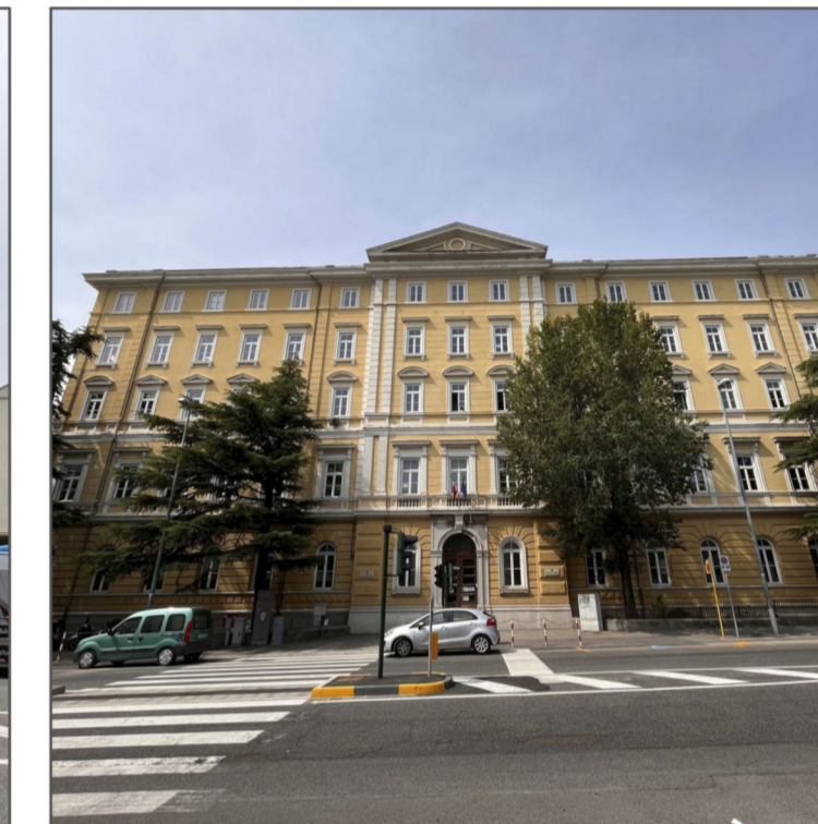
3 Via Italo Svevo Istituto comprensivo "Italo Svevo" (scuola primaria e media), Scuola dell'infanzia "Don Chalvier"
