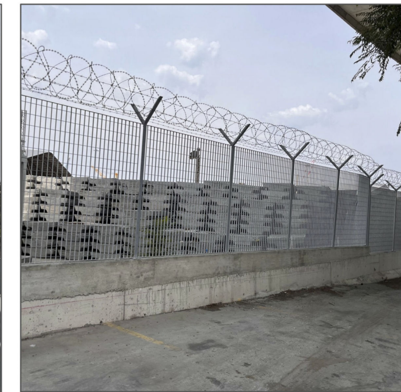
14 Via degli alti forni impianto di depurazione di Servola AcegasApsAmga, recinzione lato aree portuali ISPS
