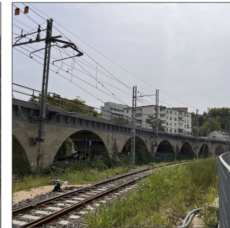
13 Linee ferroviarie alta e bassa elettrificate in servizio, autorizzazione RFI per lavori in prossimità
