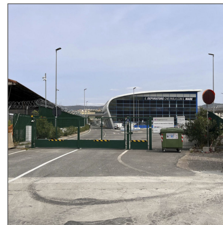
15 Via degli altofori Impianto di depurazione di Servola AcegasApsAmga
