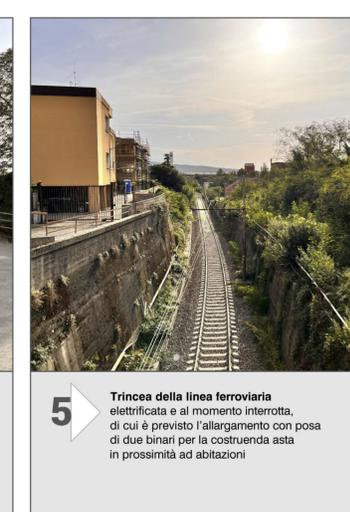
**5** Trincea della linea ferroviaria elettrificata e al momento interrotta, di cui è previsto l'allargamento con posa di due binari per la costruenda asta in prossimità ad abitazioni
