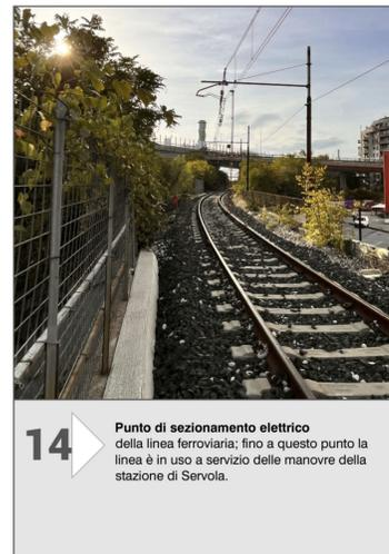
**14** Punto di sezionamento elettrico della linea ferroviaria; fino a questo punto la linea è in uso a servizio delle manovre della stazione di Servola.
