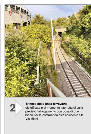
**2** Trincea della linea ferroviaria elettrificata e al momento interrotta di cui è previsto l'allargamento con posa di due binari per la costruenda asta adiacente alla Via Miani
