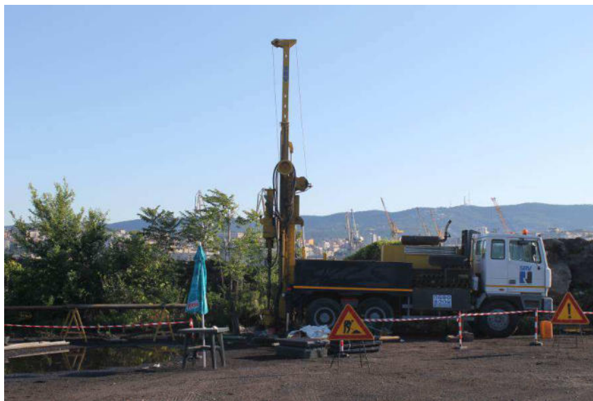
Foto n° 1 – Sonda autocarrata "NENZI – GELMA 2" utilizzata (Posizione NS3).
