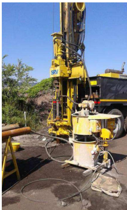
Foto n° 6 – Fasi cementazione esterna tubo PVC
