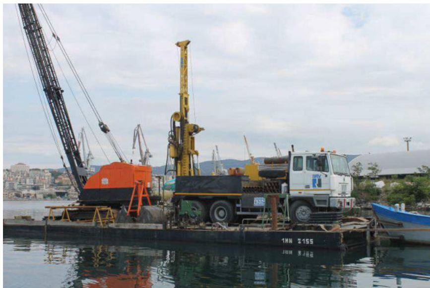
Foto n° 2 – Sonda autocarrata "NENZI – GELMA 2" a mare su pontone (Posizione NS4).
