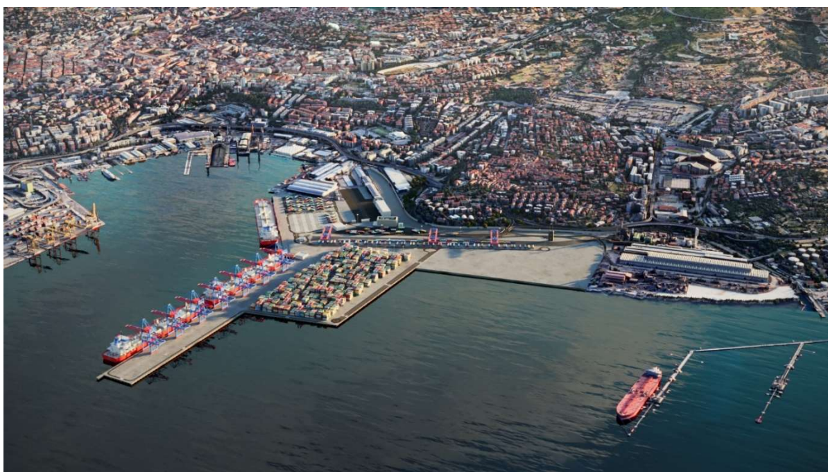
Figura 1: rendering complessivo dello sviluppo nell'interezza funzionale e ad opere completate, vista aerea da mare
