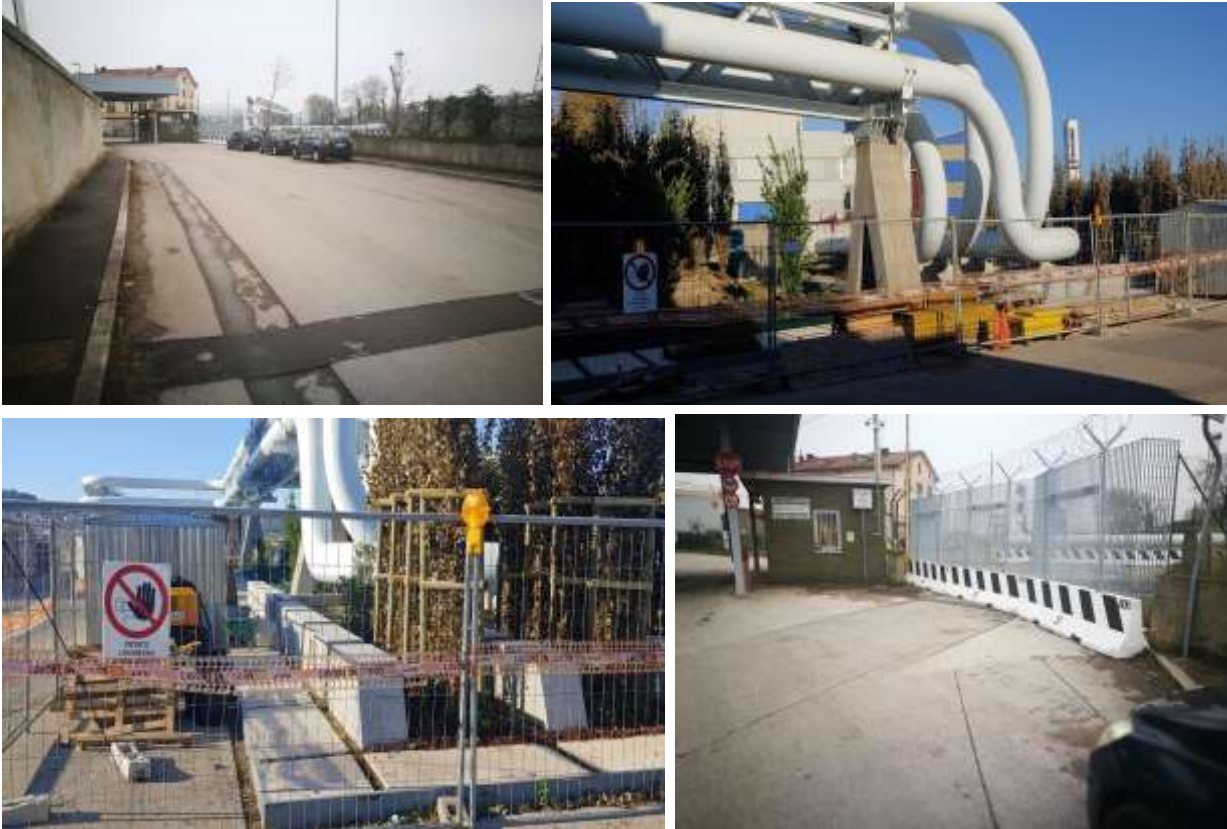
Figura 5-16 documentazione fotografica dello stato di fatto del futuro nuovo accesso da via Rio Primario
