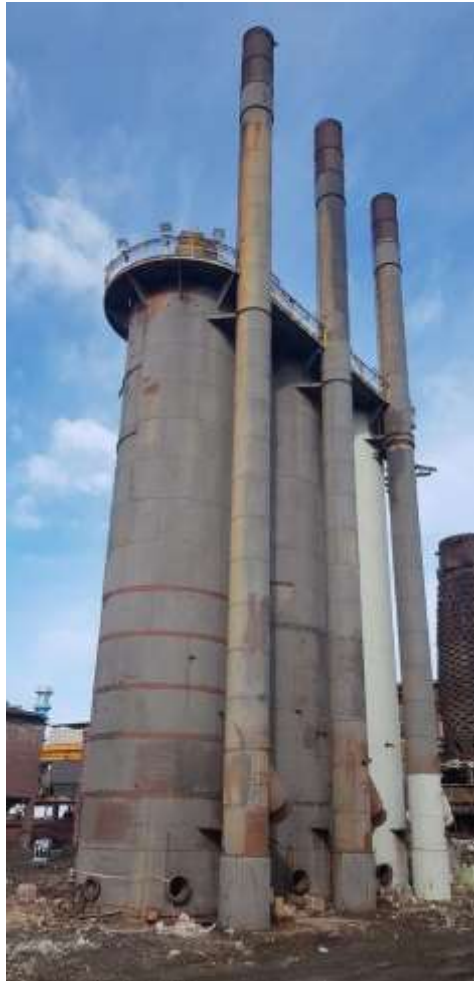
Figura 7-40 – Cowper AFO3; i due più scuri in primo piano, risalenti agli anni '20 del secolo scorso, verranno conservati e destinati a memoria dell'archeologia industriale (intervento futuro non oggetto del progetto in esame)
