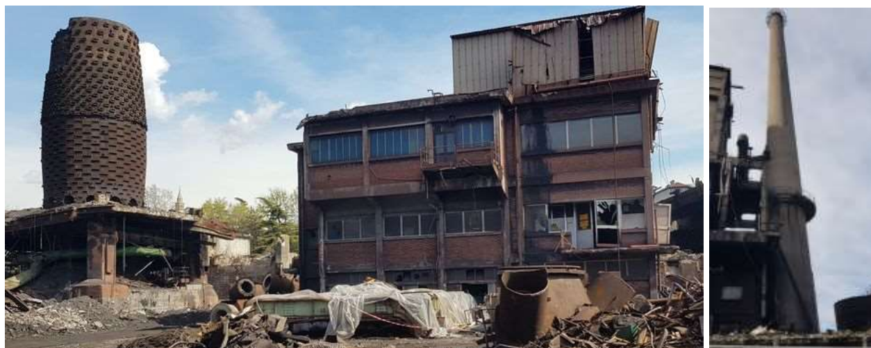
Figura 2-6 AFO2 e cabina pirometri ad aprile 2021 e, a destra, il camino E1, una struttura in c.a. alta più di 50m
