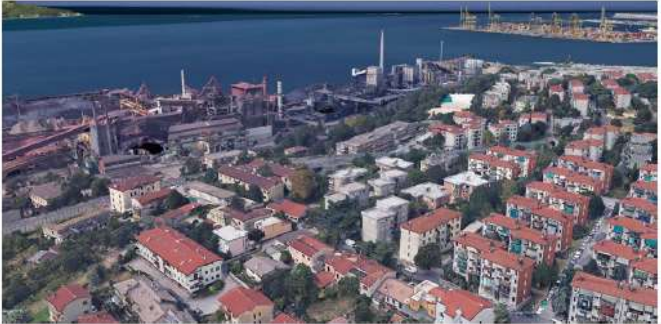
Figura 7-32 – L'area nei pressi dello svincolo di raccordo alla GVT: vista ante operam
