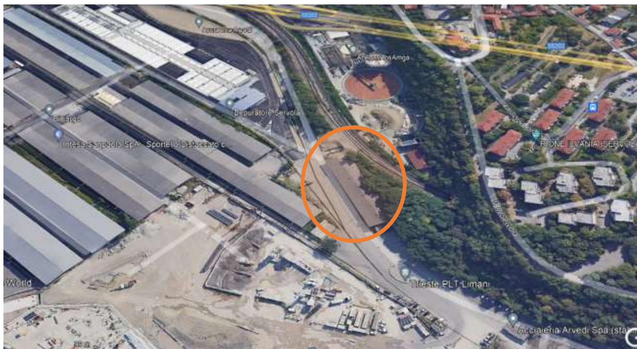
Figura 5-58 localizzazione del capannone da demolire per la realizzazione del rilevato ferroviario (nel tondo arancione)
