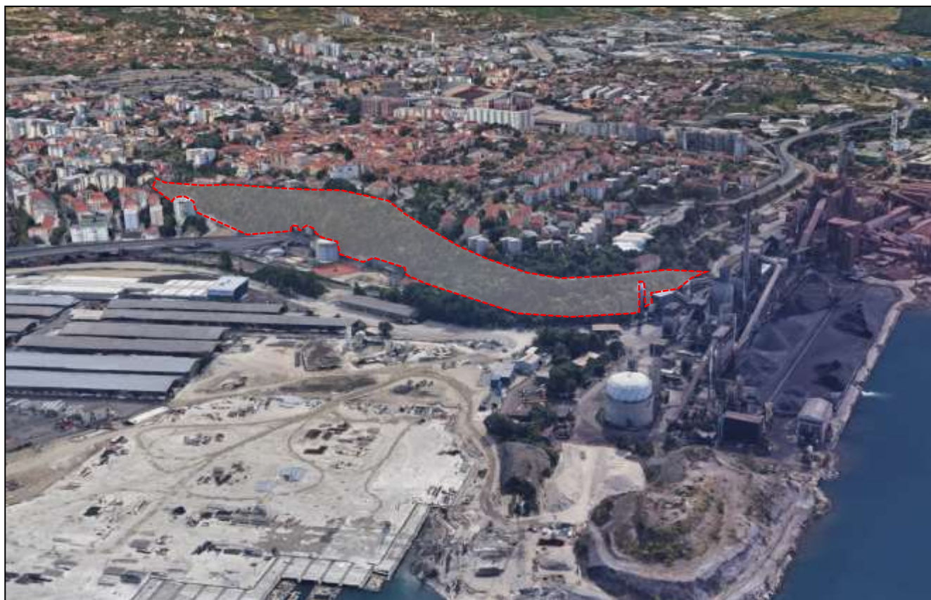
Figura 6-48 – Particolare dell’area d’attenzione, soggetta ad eventi franosi nella fascia a monte dell’area del vecchio depuratore di Servola
