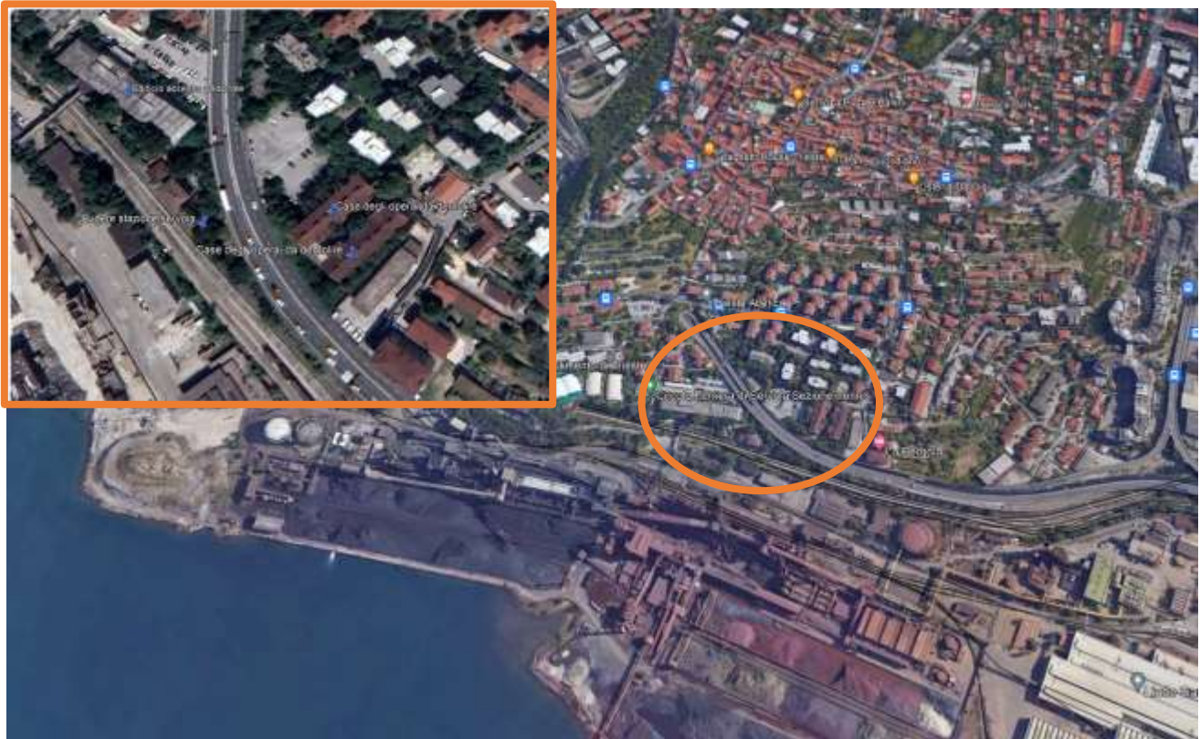
Figura 5-60 Edifici da demolire nell'area della nuova connessione alla GVT: collocazione nel cerchio arancione e ingrandimento in alto a destra
