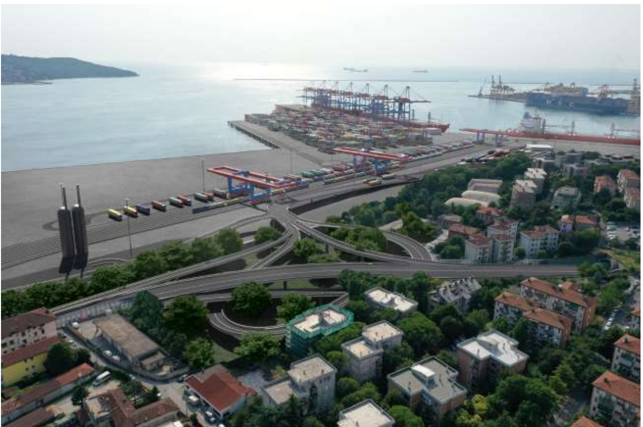
Figura 7-33 – Particolare dello svincolo con veduta a volo d'uccello in direzione della piattaforma logistica (Fonte: modellazione 3D e fotoinserimento delle Opere in progetto, Studio LAND, 2023)
