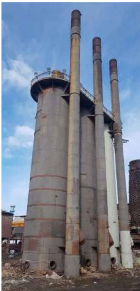
Figura 5-20: Cowper AFO3; i due più scuri in primo piano, risalenti agli anni '20 del secolo scorso, vanno conservati e destinati a memoria dell'archeologia industriale
