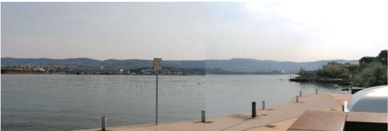
Figura 7-27 – Vista del terminal SIOT e dell’aera delle Noghère da Muggia
