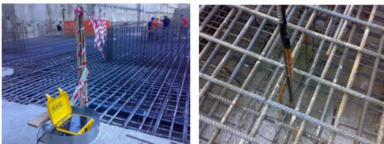
Figura 12: Centralina di registrazione e controllo dei termometri (a sinistra); configurazione termometri (a destra).
