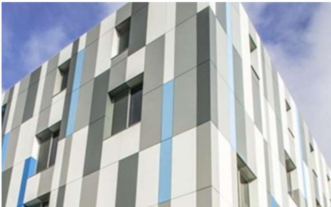
*Figura 10: Esempio di pannellatura con finitura a polvere*
