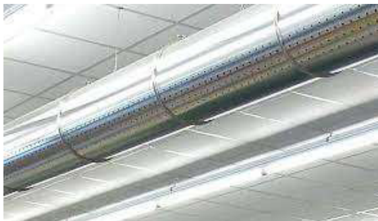
Canale microforato in lamiera per installazione a vista
