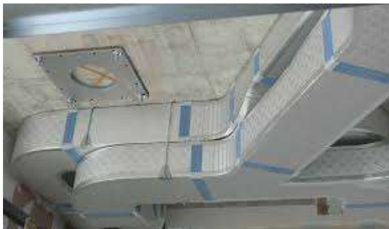
Canale in pannello preisolato per installazione a controsoffitto
