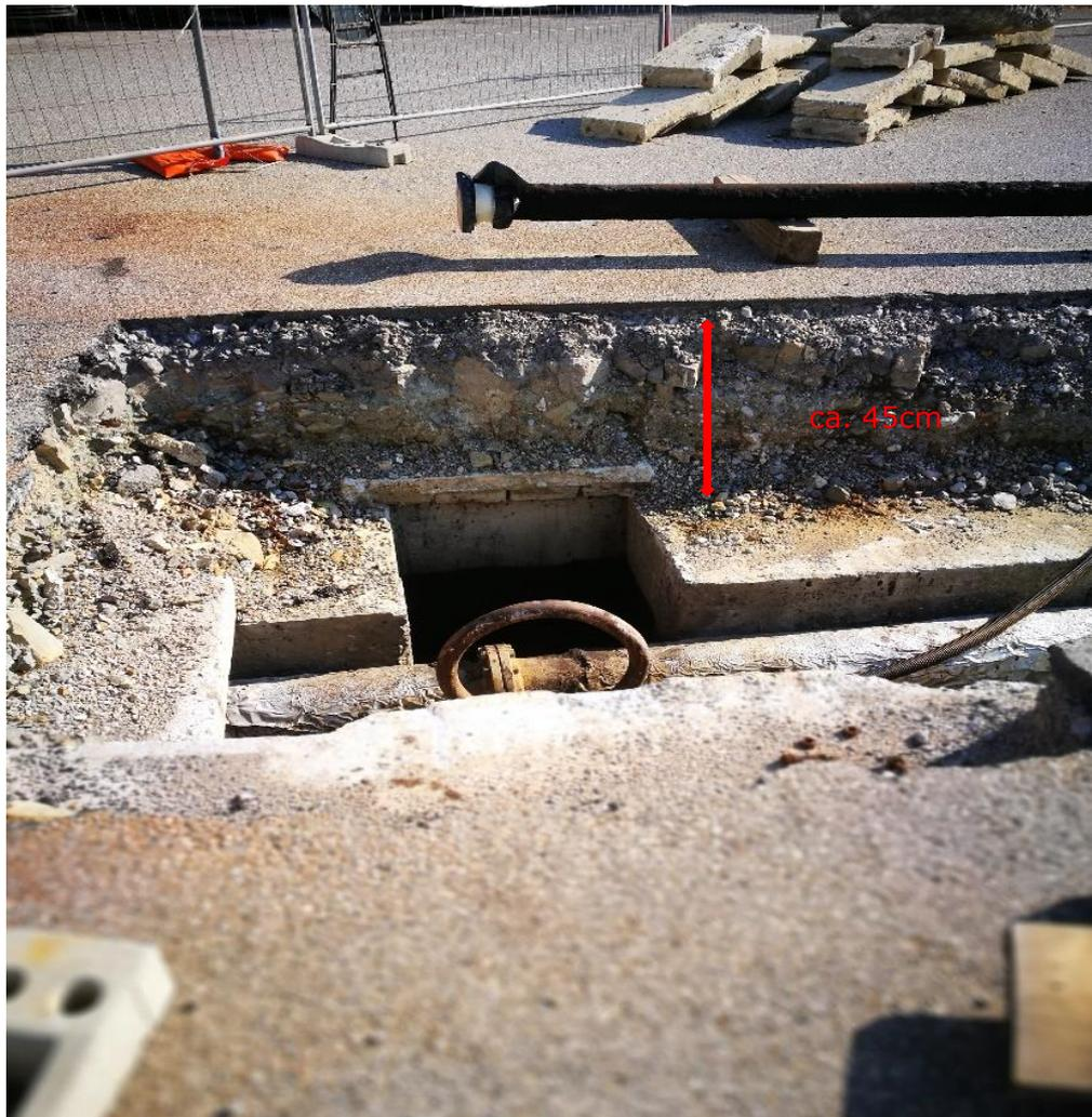
*Figura 6 - sovrastruttura stradale del tipo nella zona del piazzale*
