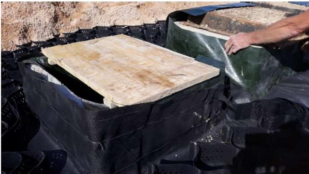
Figura 5.12: Esempio della posa della geomembrana nell'intorno dei pozzetti (sito inquinato "Acquario" a Muggia)
