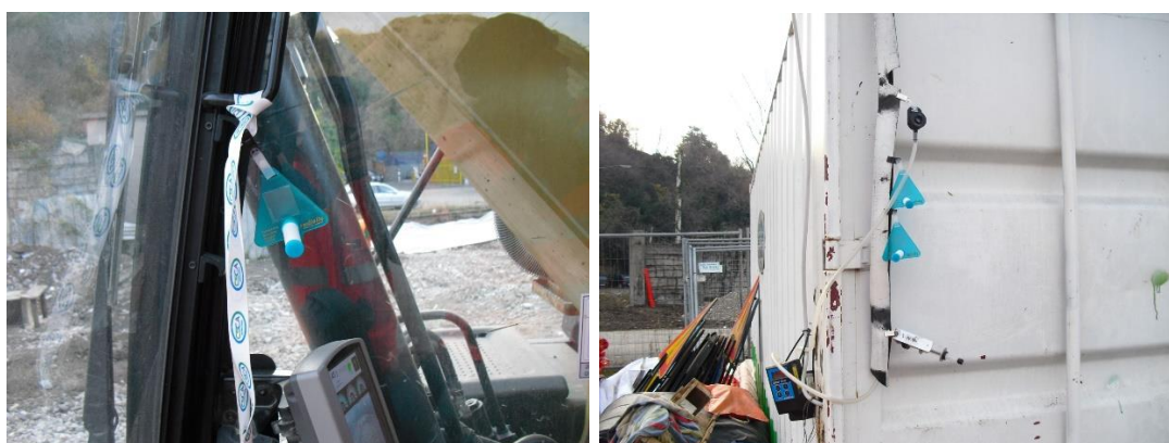
Figura 1.9 Foto dei monitoraggi ante operam effettuati nell'ambito del cantiere
