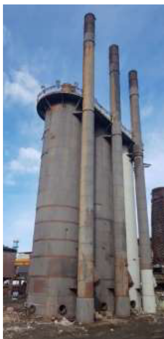
Figura 6-28: Cowper AF03; i due più scuri in primo piano, risalenti agli anni '20 del secolo scorso, verranno conservati e destinati a memoria dell'archeologia industriale (intervento futuro non oggetto del progetto in esame)
