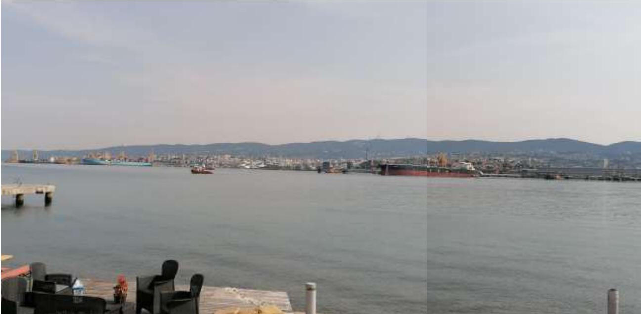
Figura 6-23: Il ponte petroli con nave idrocarburi attraccata, a sinistra Molo VII
