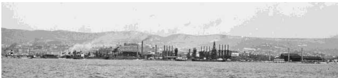
Figura 3-6: la ferreria vista dal mare negli anni '60
