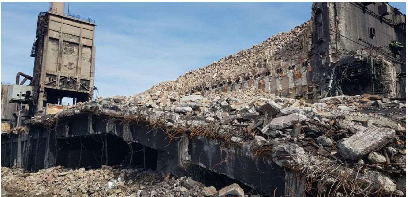
Figura 3-8 a cokeria vista dal lato mare e in direzione della torre di caricamento del fossile
