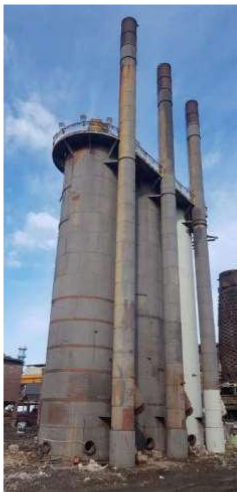
Figura 3-33: Cowper AFO3; i due più scuri in primo piano, risalenti agli anni '20 del secolo scorso, vanno conservati e destinati a memoria dell'archeologia industriale
