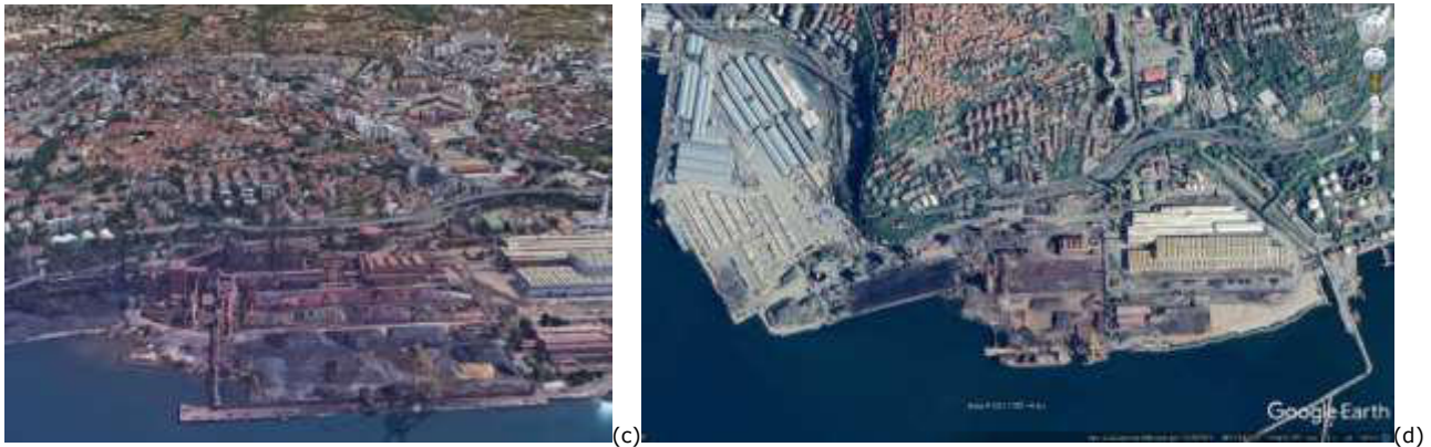
Figura 3-3: nella coppia di foto in alto volo aereo degli anni '60 con la banchina in costruzione e vista da Google Earth con la ferriera attiva (fino all'aprile 2020). Nella coppia di foto sotto vista aerea del 1943 e a ottobre 2021 (Google Earth).
