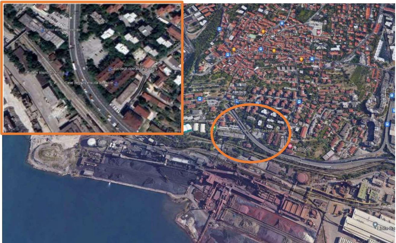
Figura 3-67 Edifici da demolire nell'area della nuova connessione alla GVT: collocazione nel cerchio arancione e ingrandimento in alto a destra
