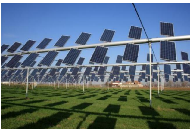
Figura 16: rete di cavi di acciaio che connette i pannelli fotovoltaici.
