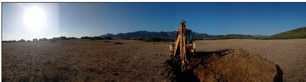
Figura 5.7 - Osservazione 3: panoramica dell'area di intervento
