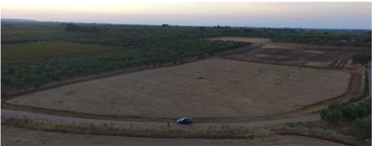
Figura 42. Foto aerea del Corpo H, ripresa da sud-est in direzione nord-ovest
