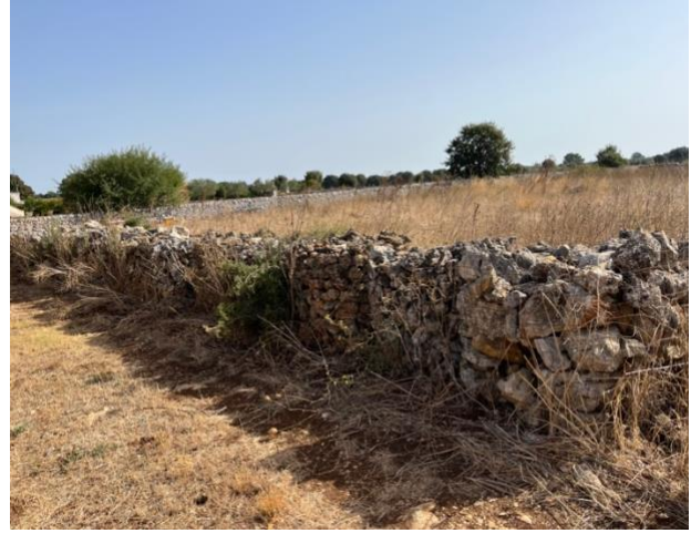
Figura 39. Dettaglio dell'elemento strutturale n° 4
