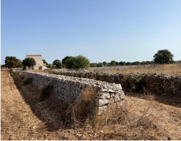
Figura 38. Dettaglio dell'elemento strutturale n° 3
