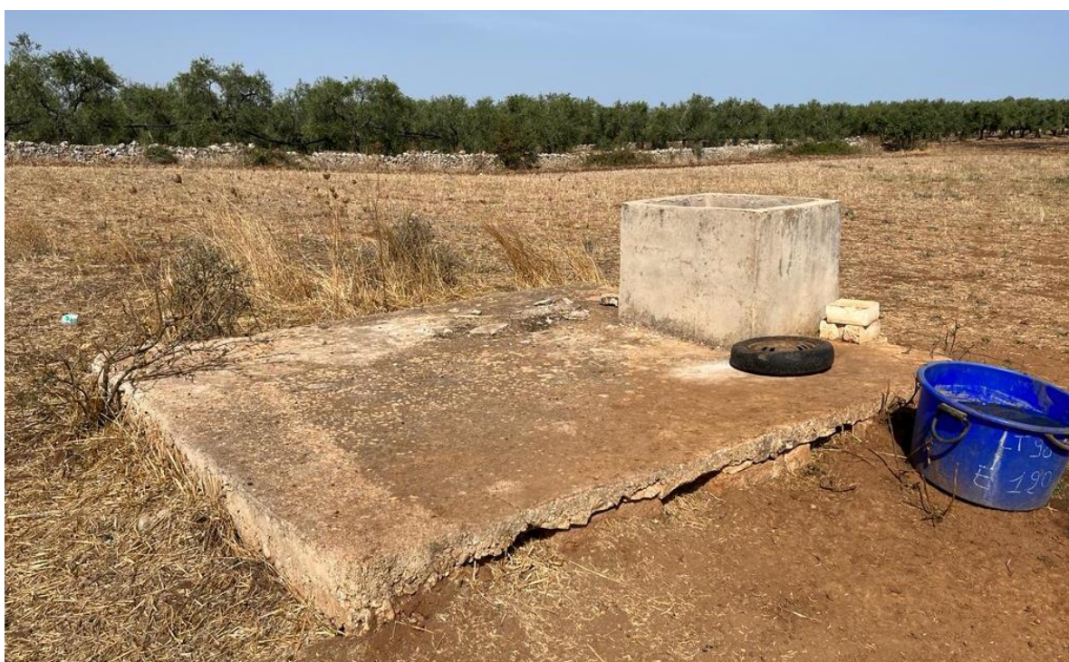
Figura 44. Dettaglio dell'elemento strutturale n° 6
