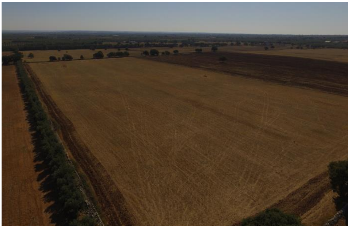
Figura 23. Foto aerea del Corpo F, ripresa da nord-ovest in direzione sud-est
