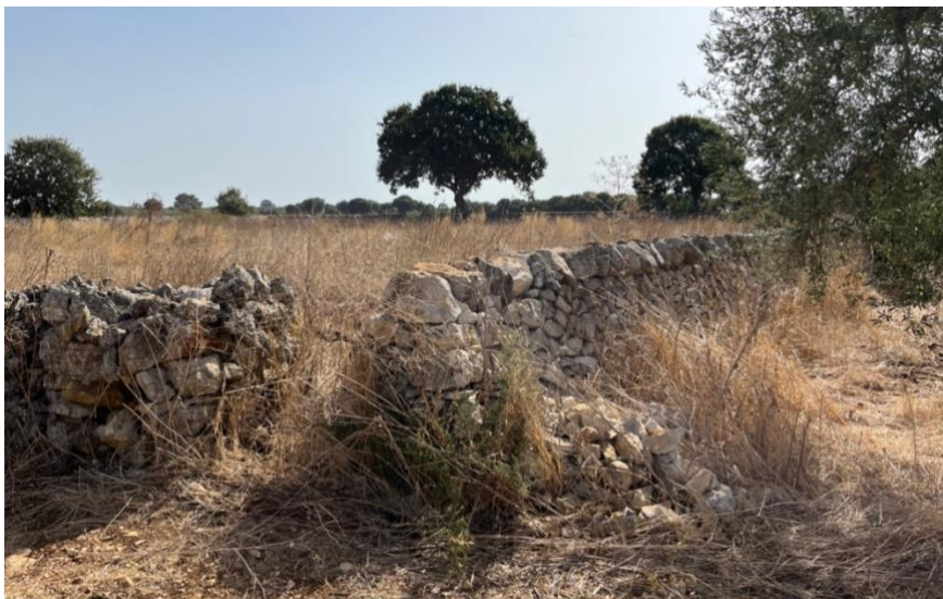
Figura 40. Dettaglio dell'elemento strutturale n° 5
