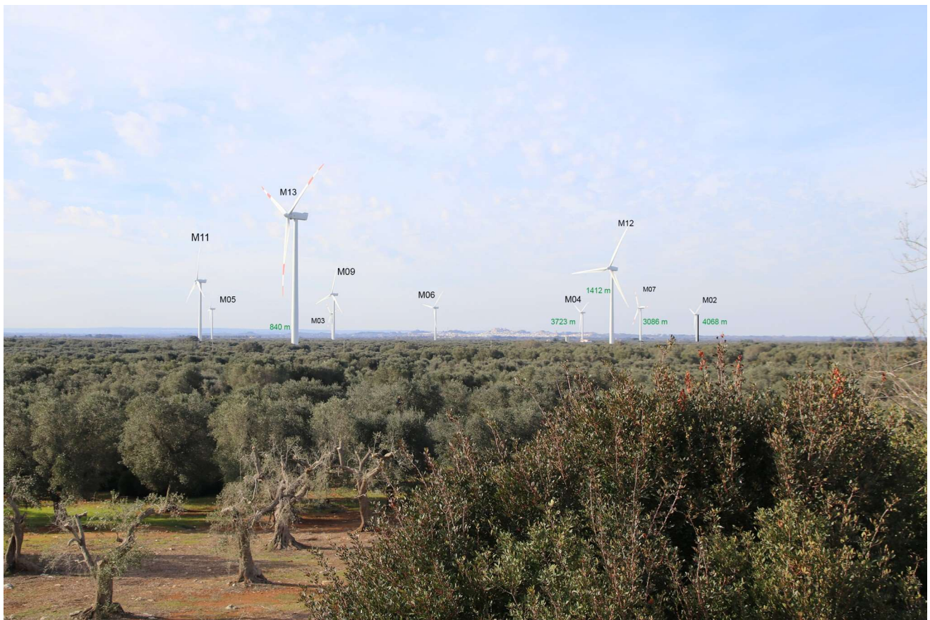
Figura 2: Impianto Eolico in territorio di Erchie (Brindisi). Aerogeneratori Gamesa G90 - Altezza al rotore m. 80, tip m. 120 Società Eolica Erchie (Realizzato). Punto di Ripresa 40.408737 17.725408 (SS 7TER) verso il baricentro impianto. Si noti come aerogeneratori con altezza pari a metà di quella di progetto sono visibili a distanza di 4000 metri.
