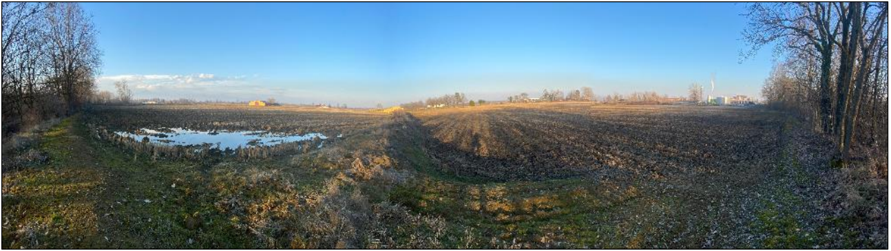
Figura 26. Area Nord - Veduta lato Sud-Ovest lungo la ferrovia Santhià-Biella.
