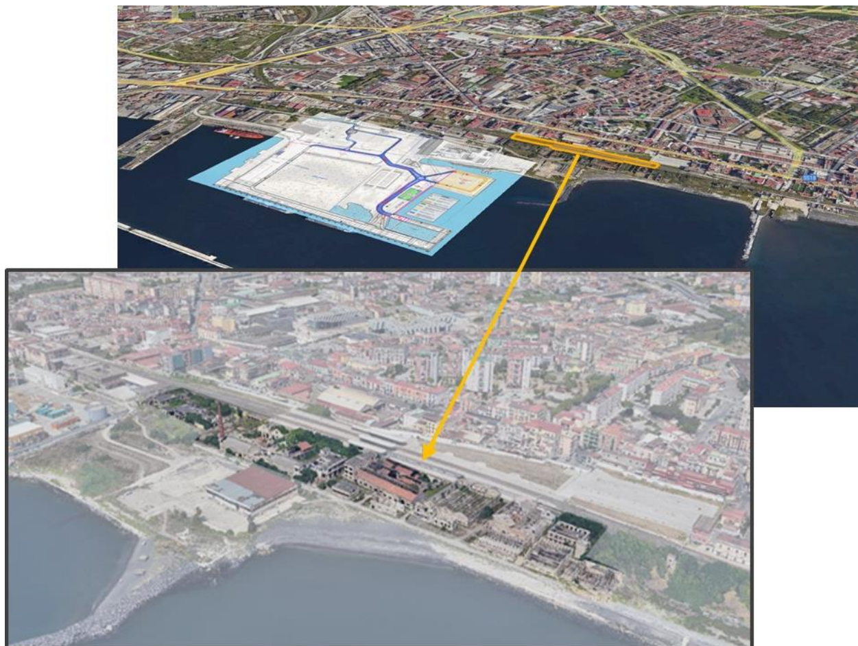
Figura 5-52: Localizzazione dei cantieri rispetto il bene culturale "Ex stabilimento metallurgico Corradini". Nel dettaglio, l'area del bene culturale
