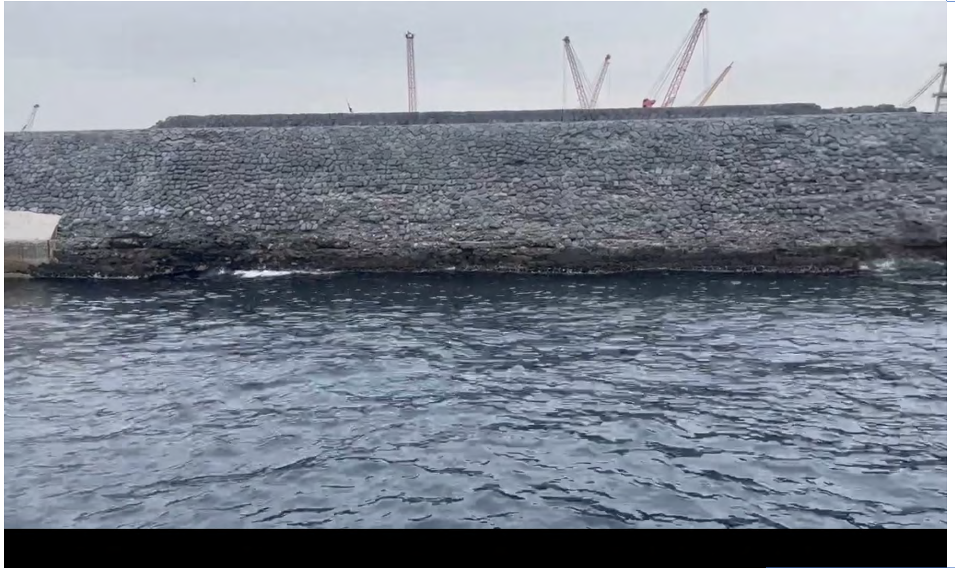
Diga Duca d'Aosta – paramento esterno
