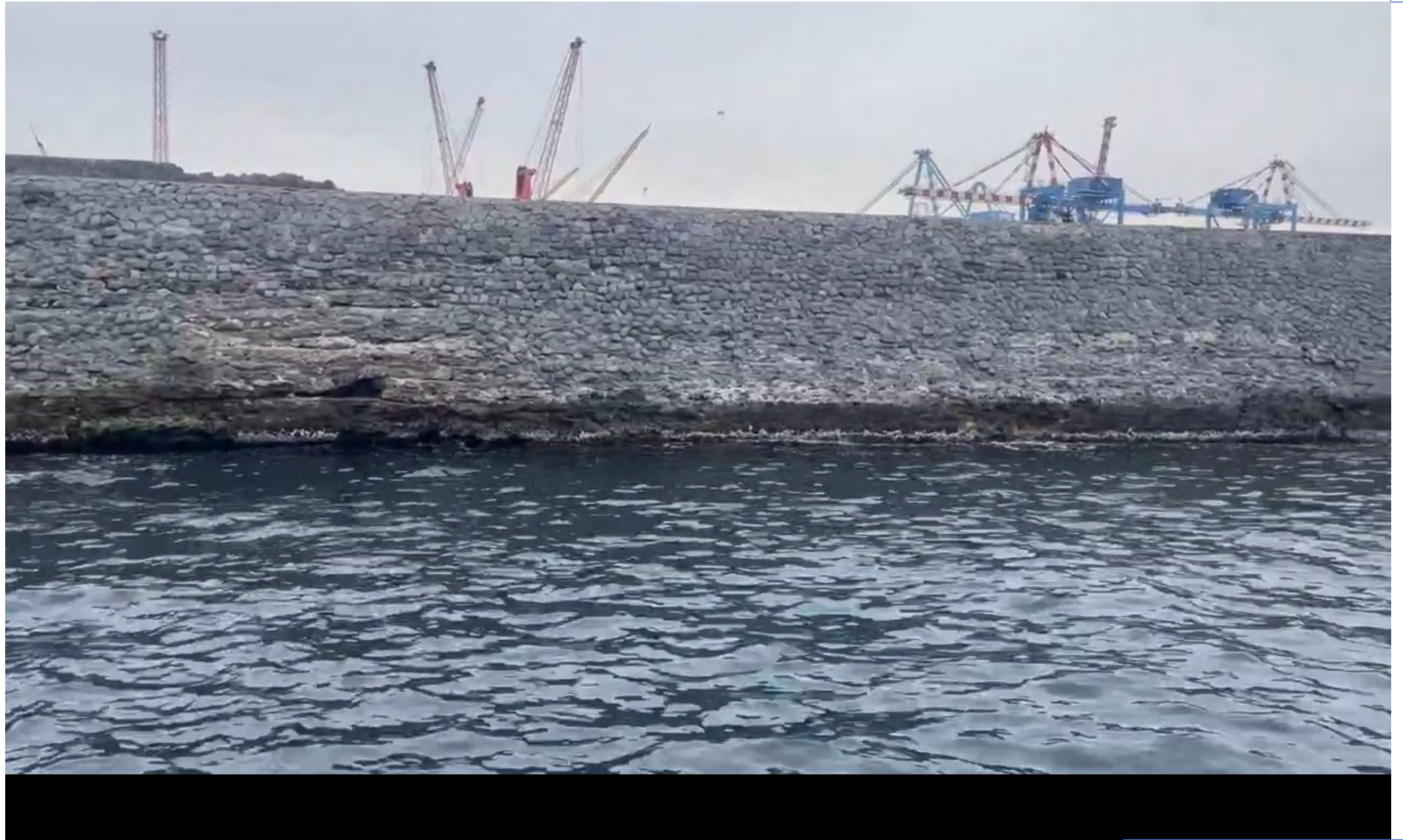
Diga Duca d'Aosta – paramento esterno
