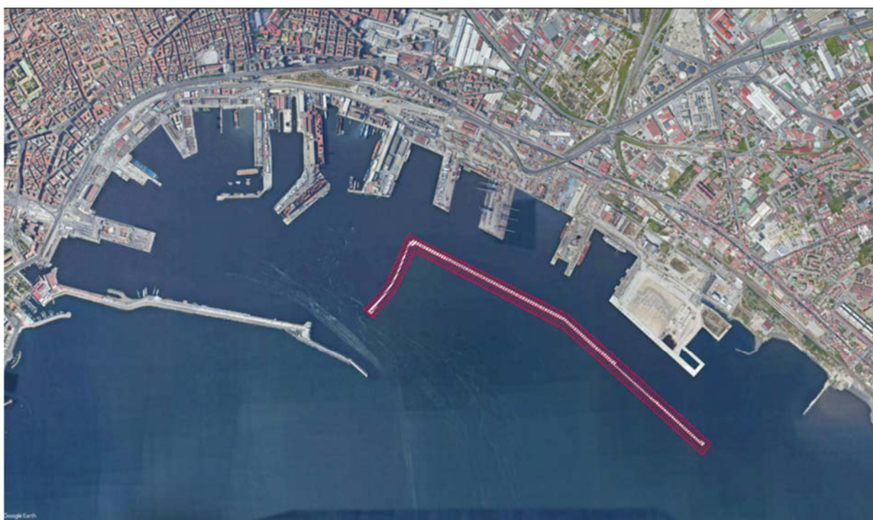
Figura 1 - Porto di Napoli – Inquadramento – Lavori di rafforzamento: Lotto B
