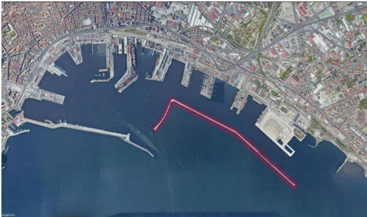
Figura 1-1 Porto di Napoli – Inquadramento – Lavori di rafforzamento: Lotto B
