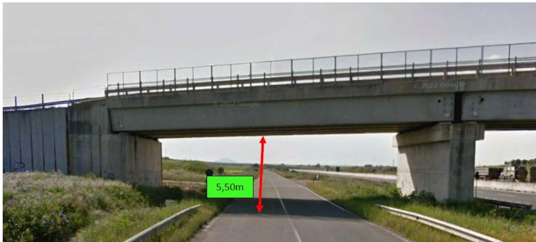
**Figura 5-51 Cavalcavia n°1 H=5,5 m.**
