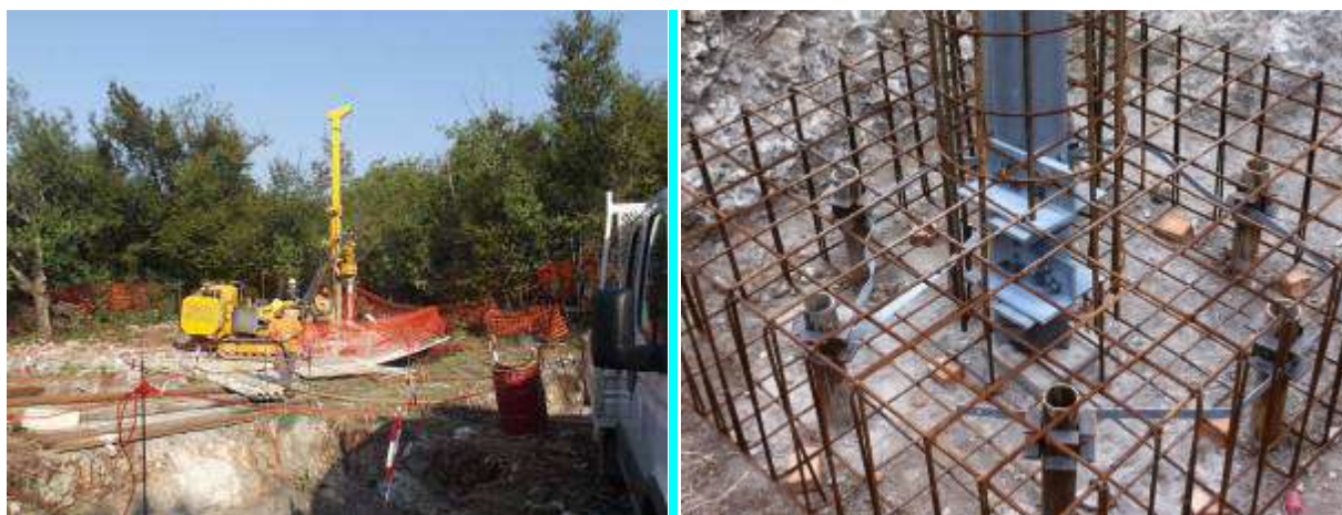
Esempio di realizzazione di una fondazione a micropali (a+b+c)
