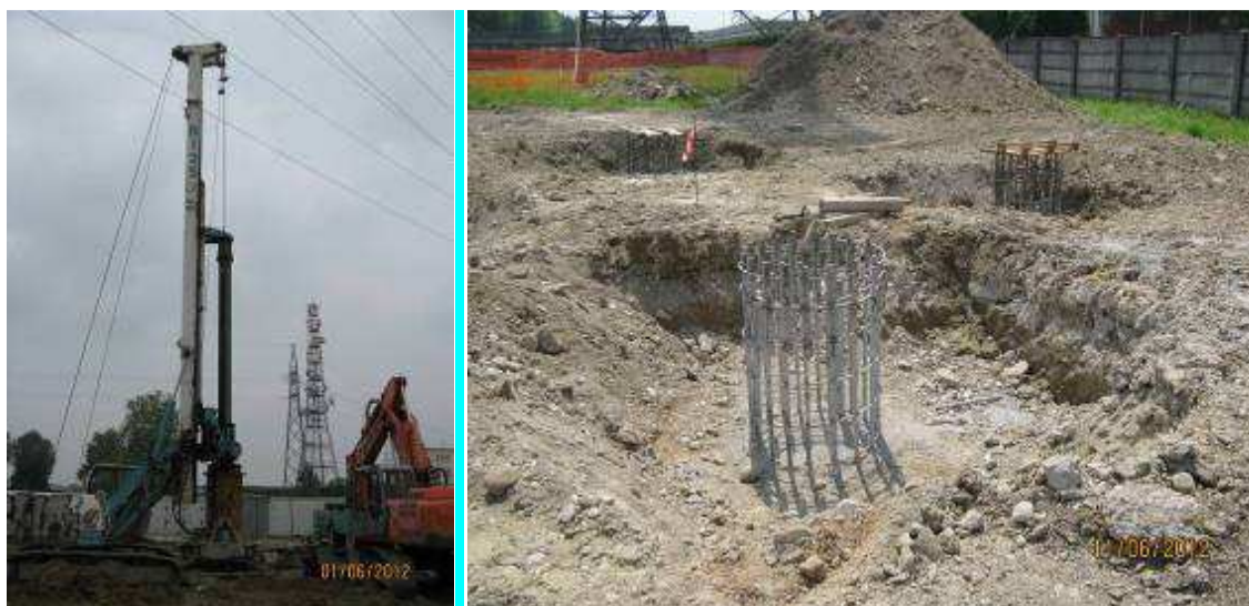
Esempio di realizzazione di una fondazione a trivellati (a+b+c)
