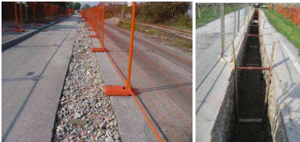
taglio dell'asfaltatura e scavo aperto
