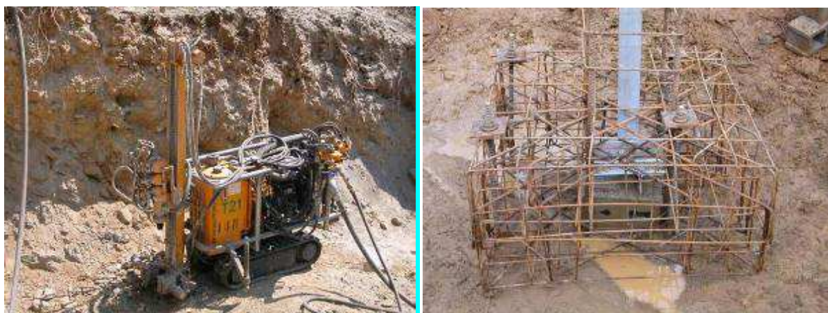
Esempio di fondazione con tiranti in roccia (a+b+c)
