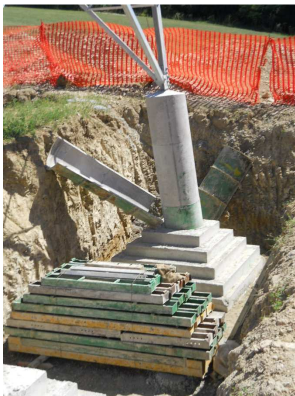
esempi di fondazione di un sostegno
