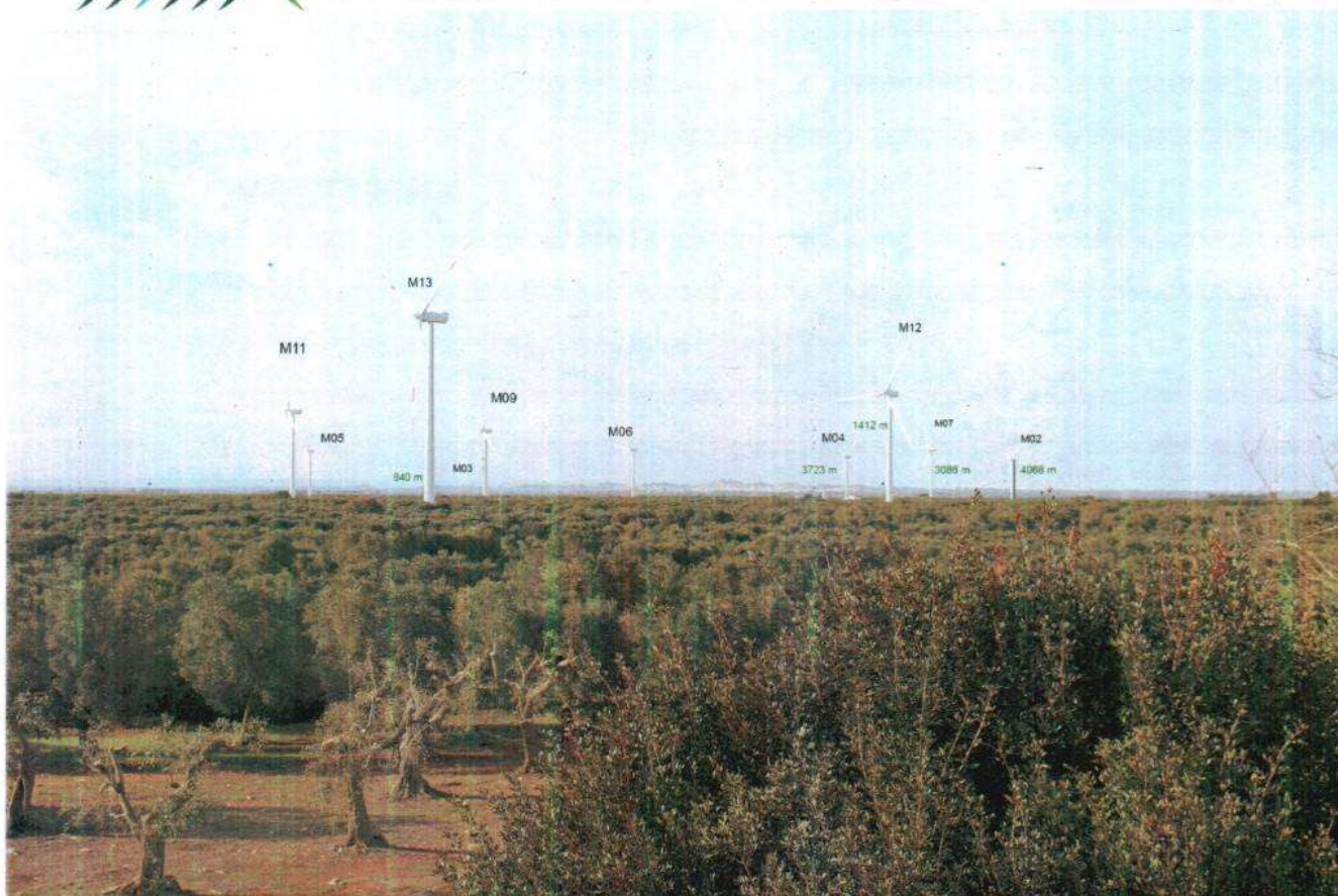
Figura 2: Impianto Eolico in territorio di Erchie (Brindisi). Aerogeneratori Gamesa G90 - Altezza al rotore m. 80, tip m. 120 Società Eolica Erchie (Realizzato). Punto di Ripresa 40.408737 17.725408 (SS 7TER) verso il baricentro impianto. Si noti come aerogeneratori con altezza pari a metà di quella di progetto sono visibili a distanza di 4000 metri.
