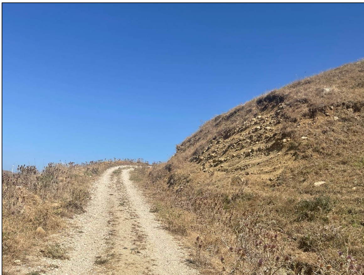
Foto 62 - Panoramica UR 20 (viabilità)
