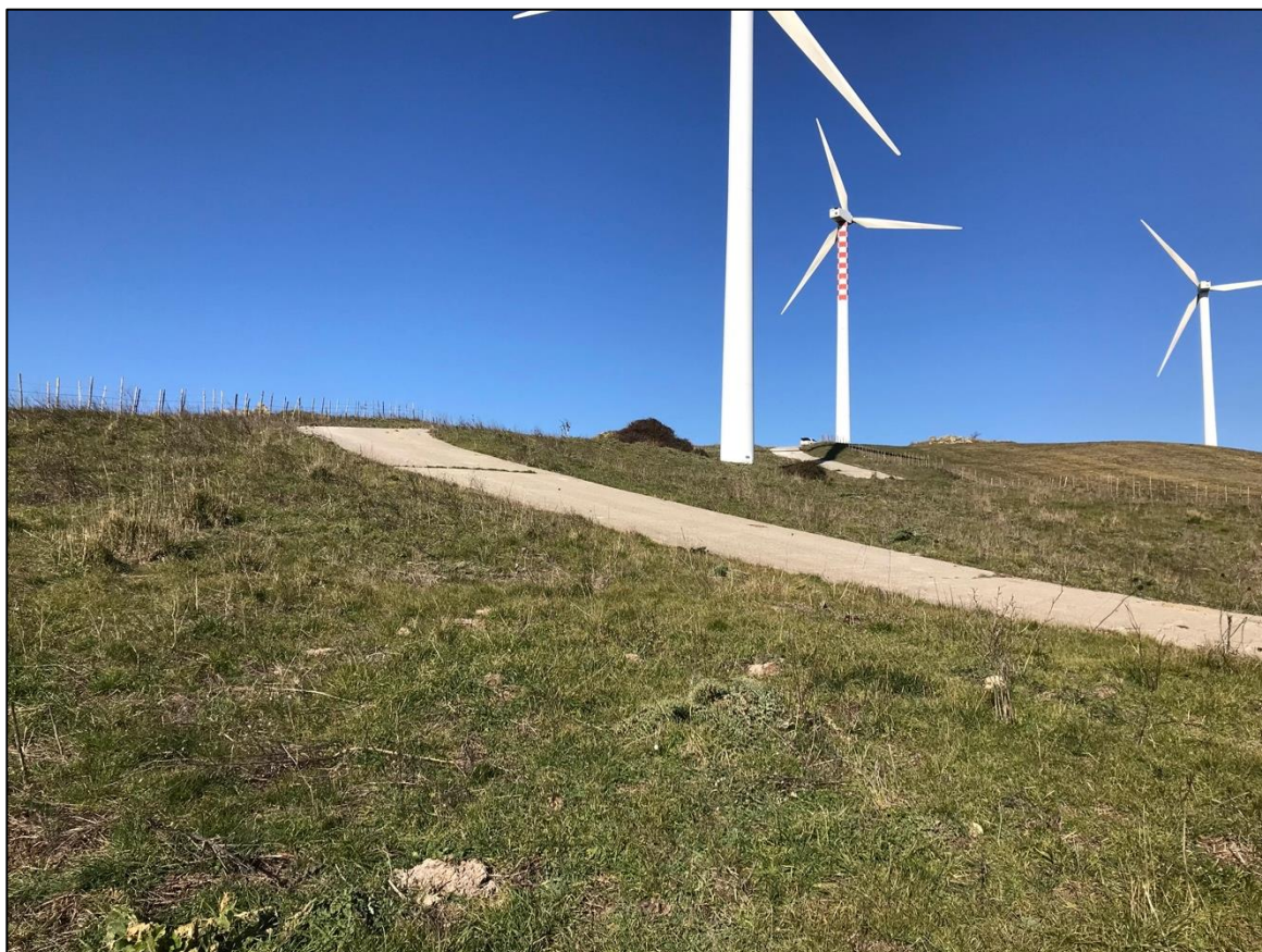
Foto 42 - Panoramica UR 12 (viabilità)
