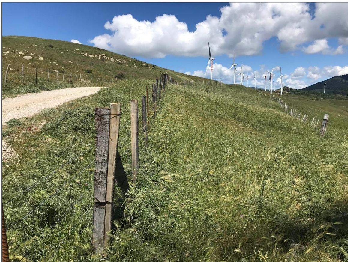
Foto 49 - Panoramica UR 16 (viabilità)
