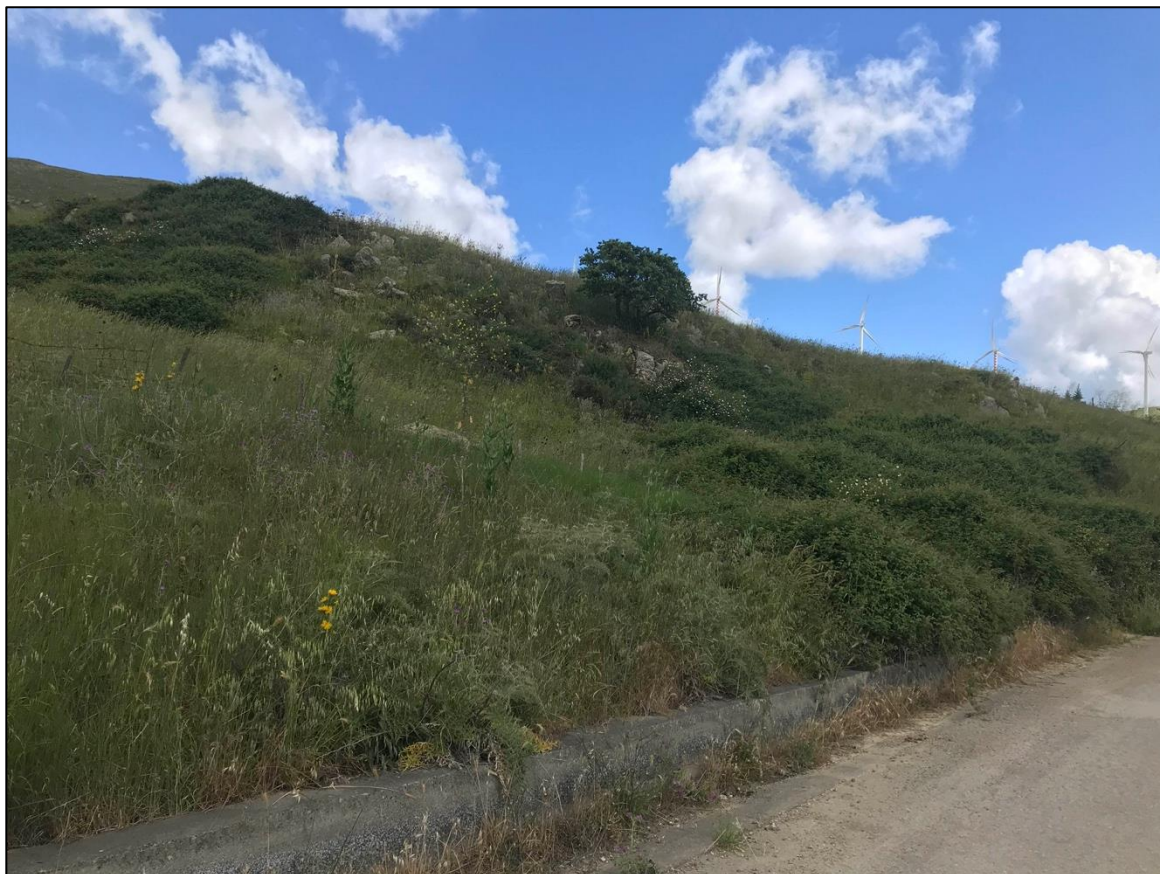
Foto 45 - Panoramica UR 14 (viabilità)
