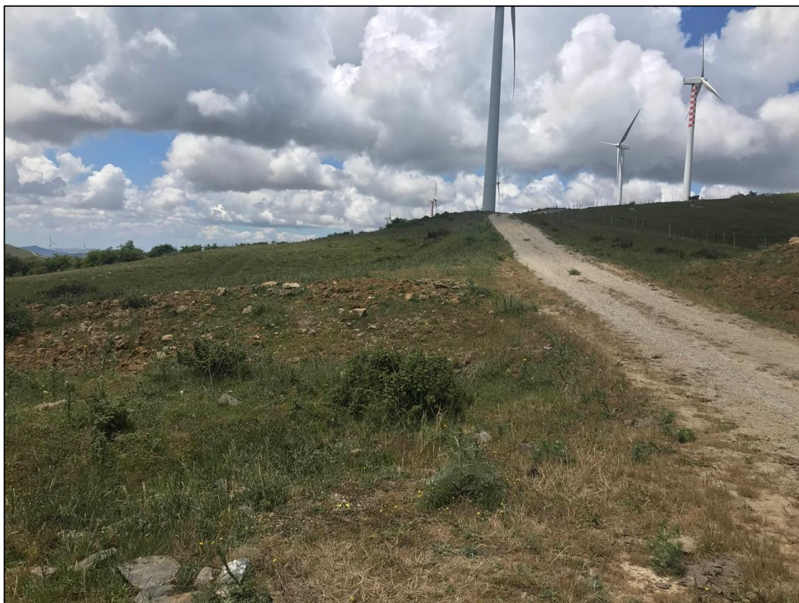
Foto 58 - Panoramica UR 19 (viabilità)
