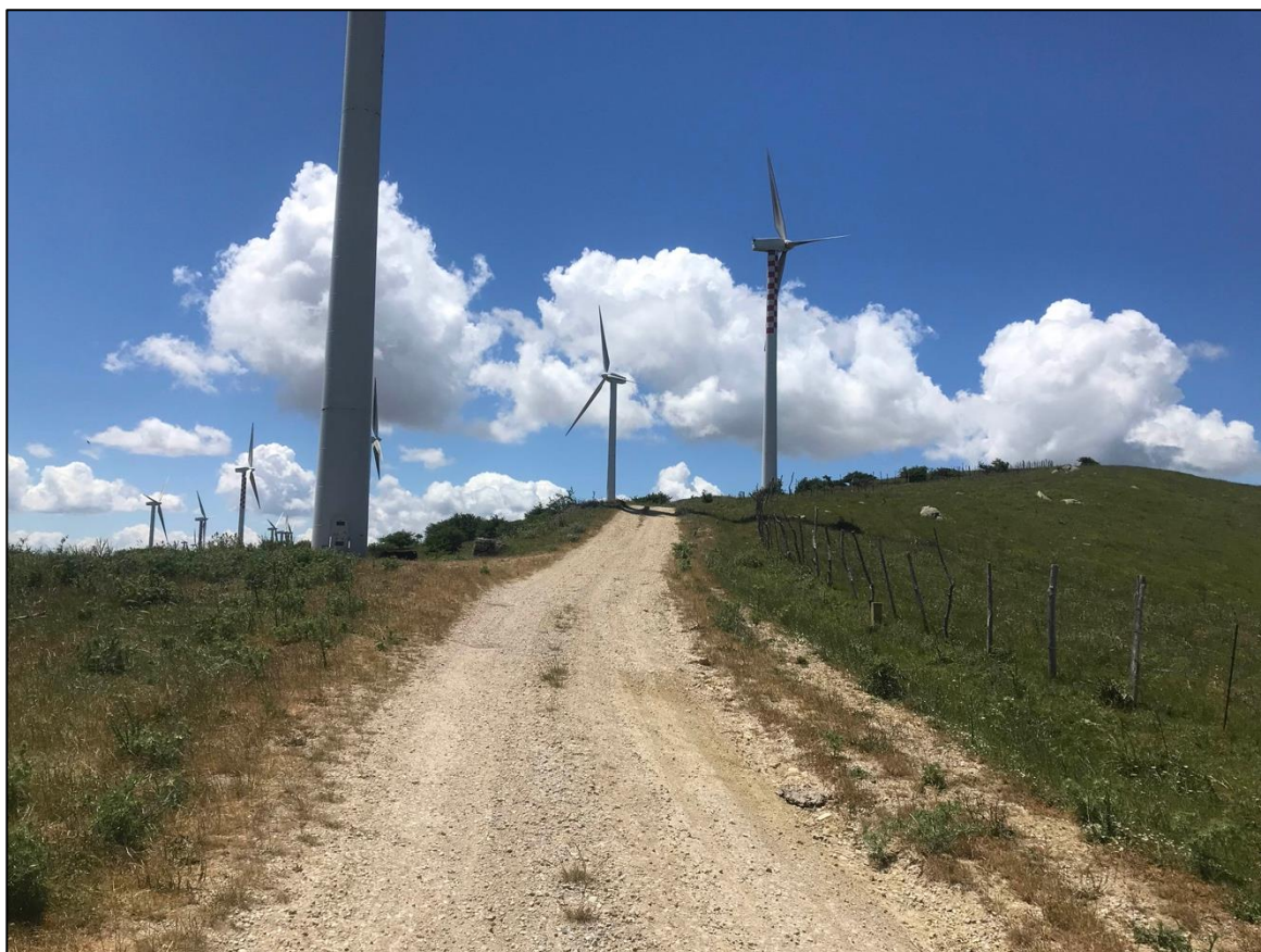
Foto 57 - Panoramica UR 18 (viabilità)
