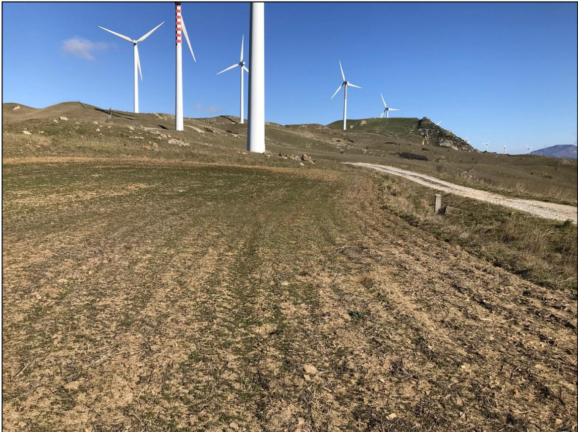
Foto 44 - Panoramica UR 13 (viabilità)
