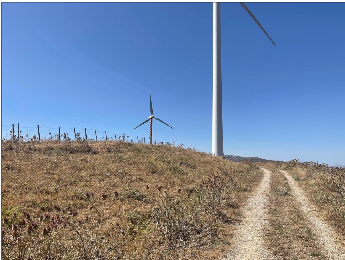
Foto 63 - Panoramica UR 21 (viabilità)
