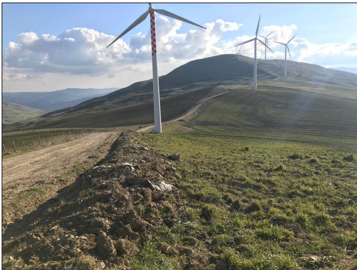
Foto 47 - Panoramica UR 15 (viabilità)
