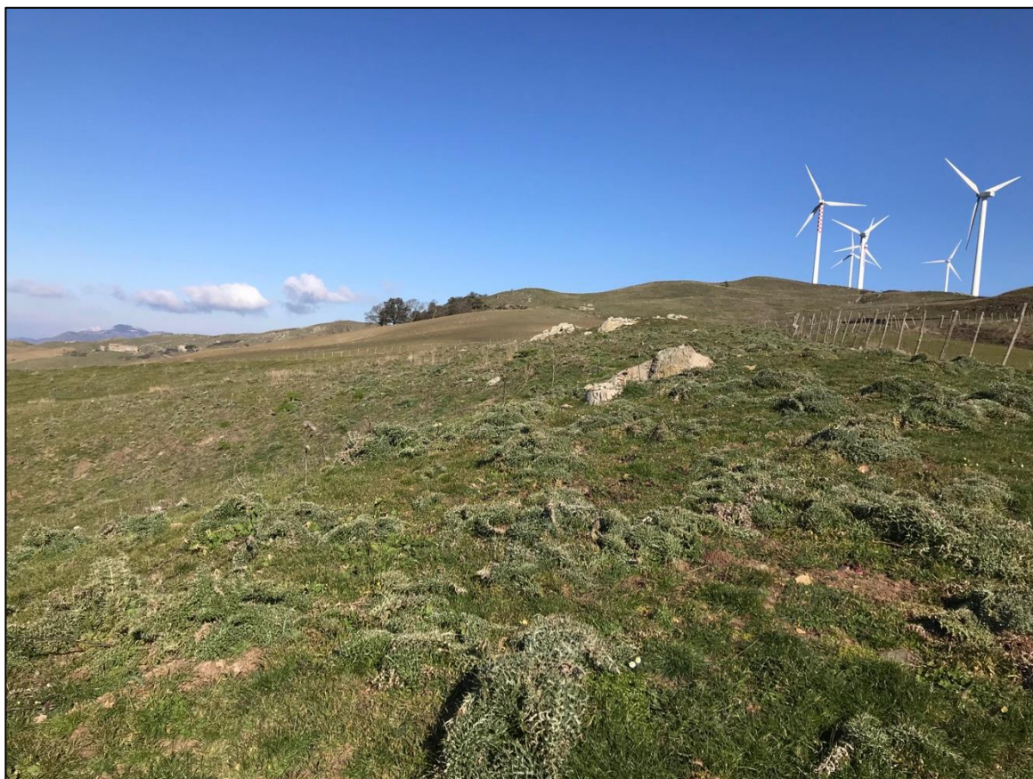
Foto 8 - Panoramica UR 02 (aerogeneratore NI01)
