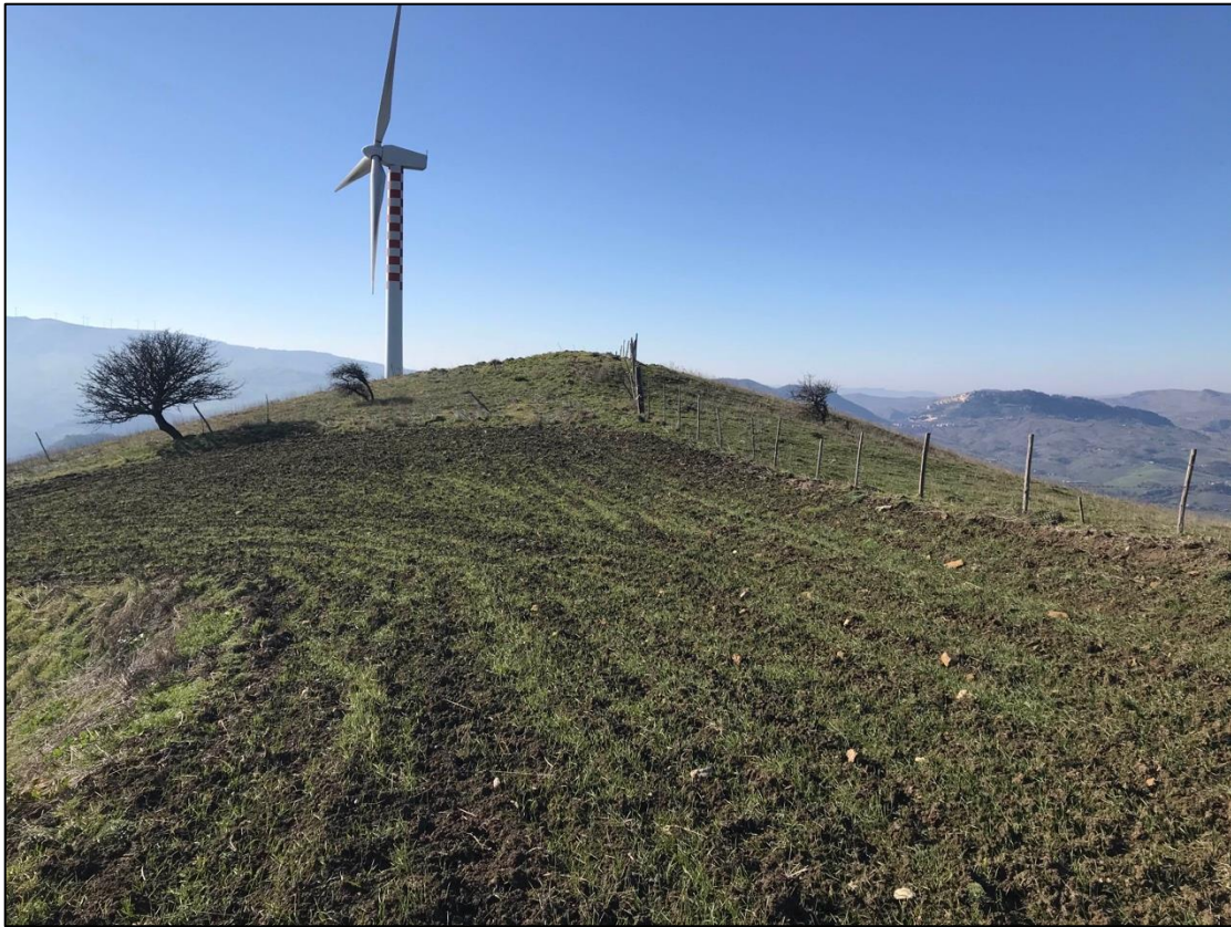
Foto 1 - Panoramica UR 01 (aerogeneratore NI01)
