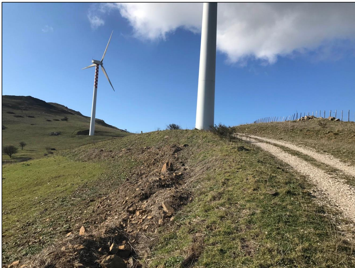
Foto 23 - Panoramica UR 06 (aerogeneratore NI04)
