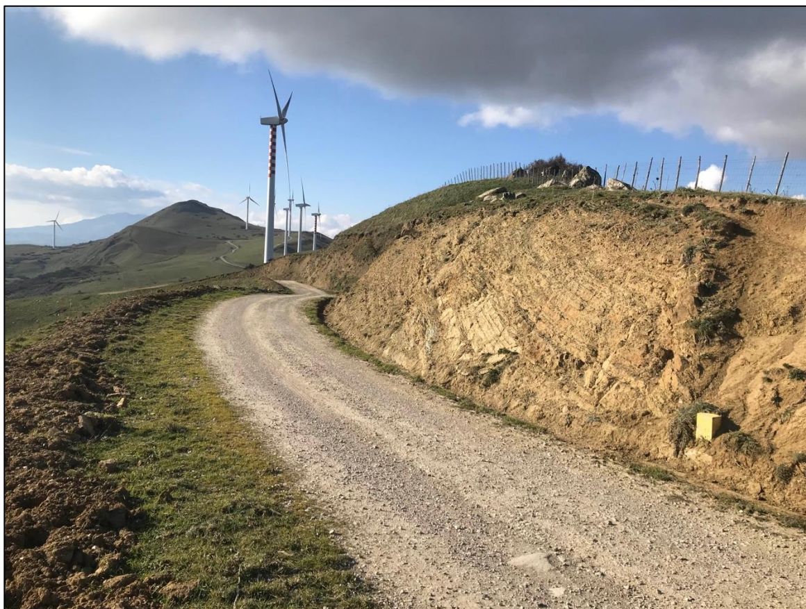
Foto 28 - Panoramica UR 08 (aerogeneratore NI06)
