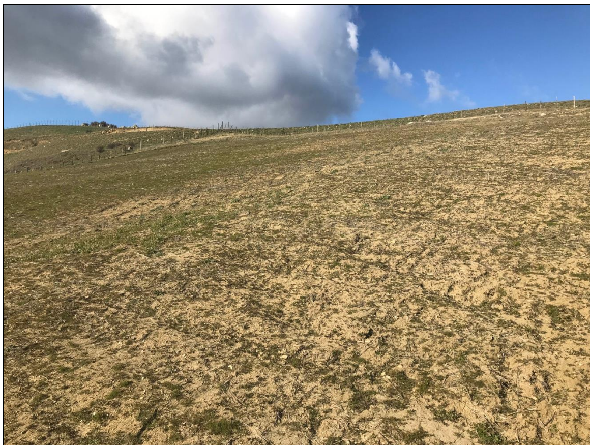
Foto 30 - Panoramica UR 08 (aerogeneratore NI06)
