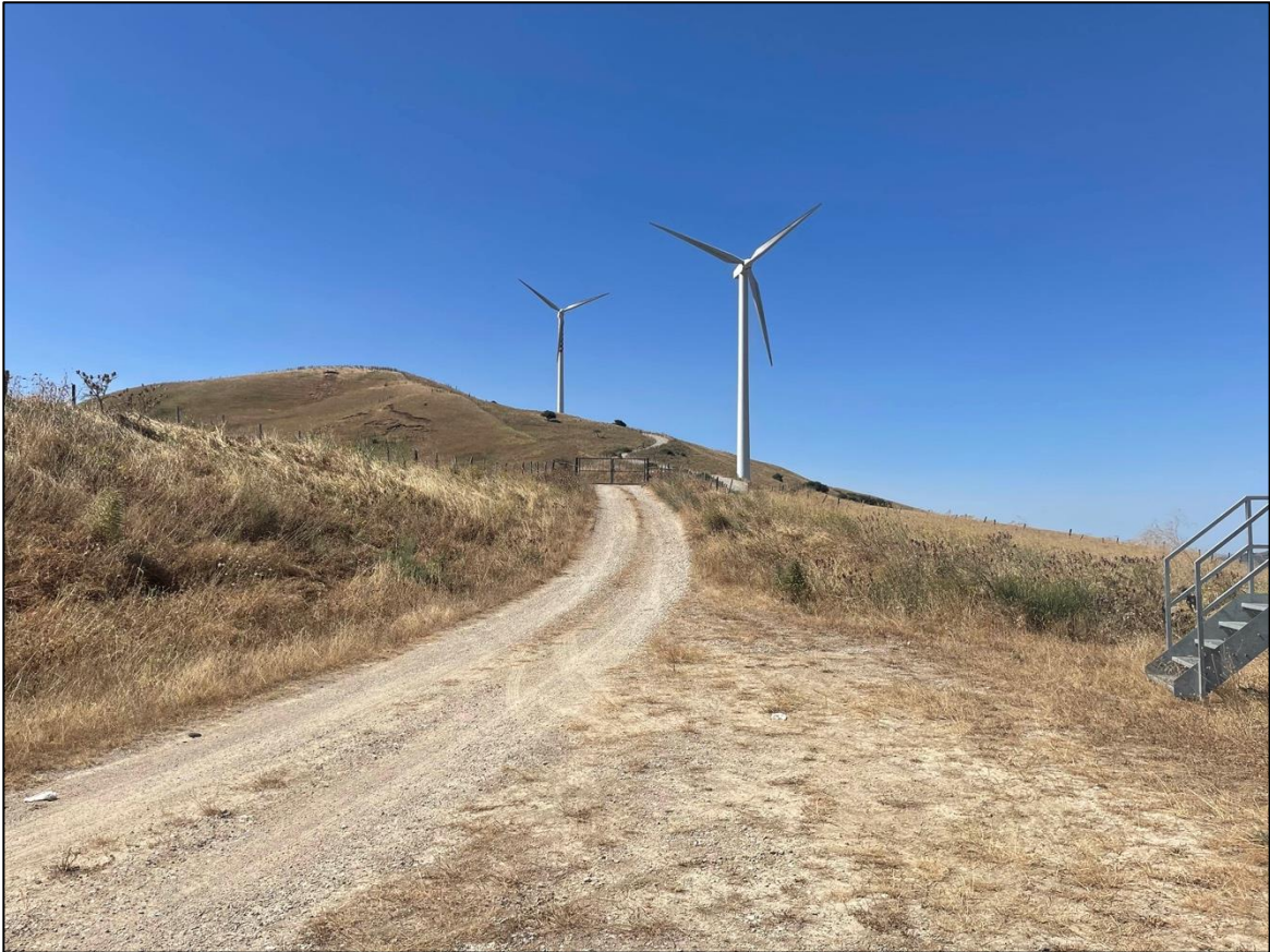
Foto 37 - Panoramica UR 10 (aerogeneratore NI13)
