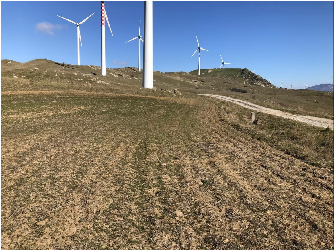
Foto 44 - Panoramica UR 13 (viabilità)
