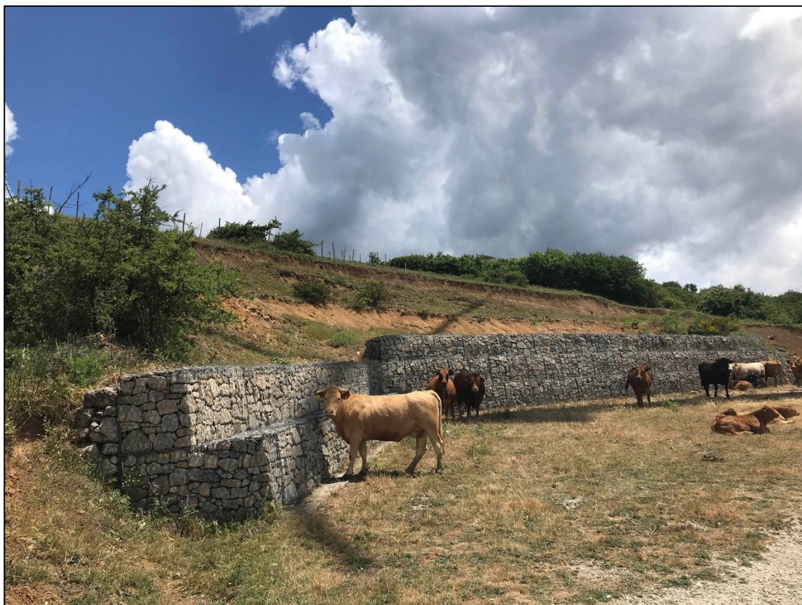
Foto 60 - Panoramica UR 19 (aerogeneratore NI11)
