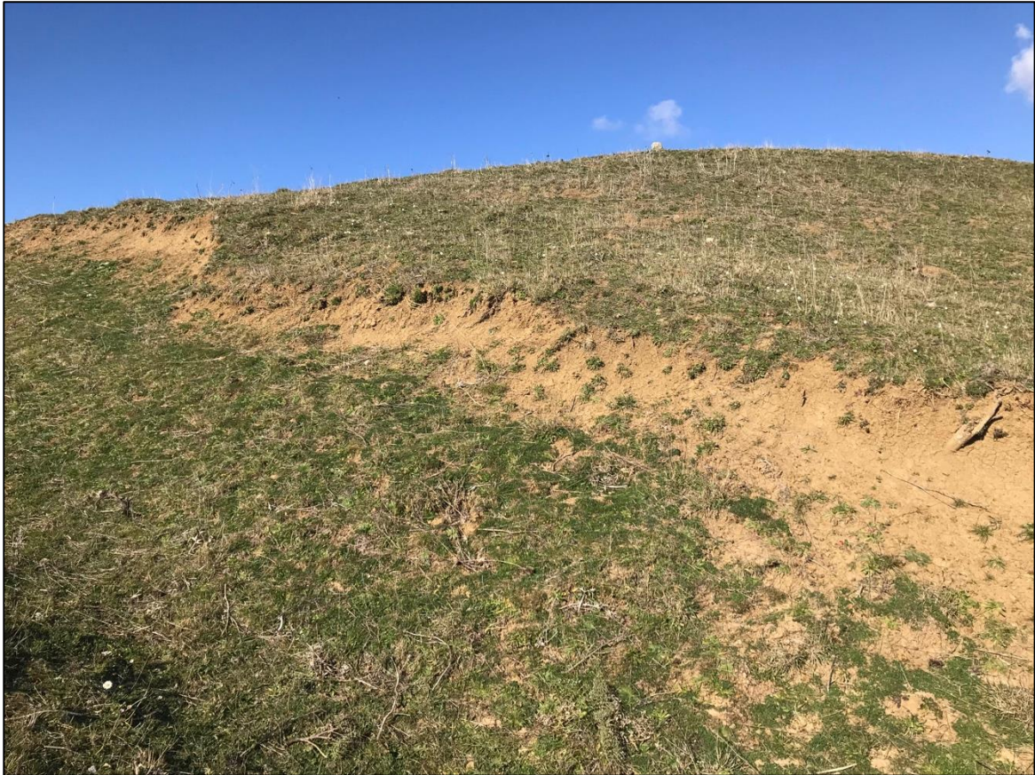
Foto 17 - Panoramica UR 04 (aerogeneratore NI03)
