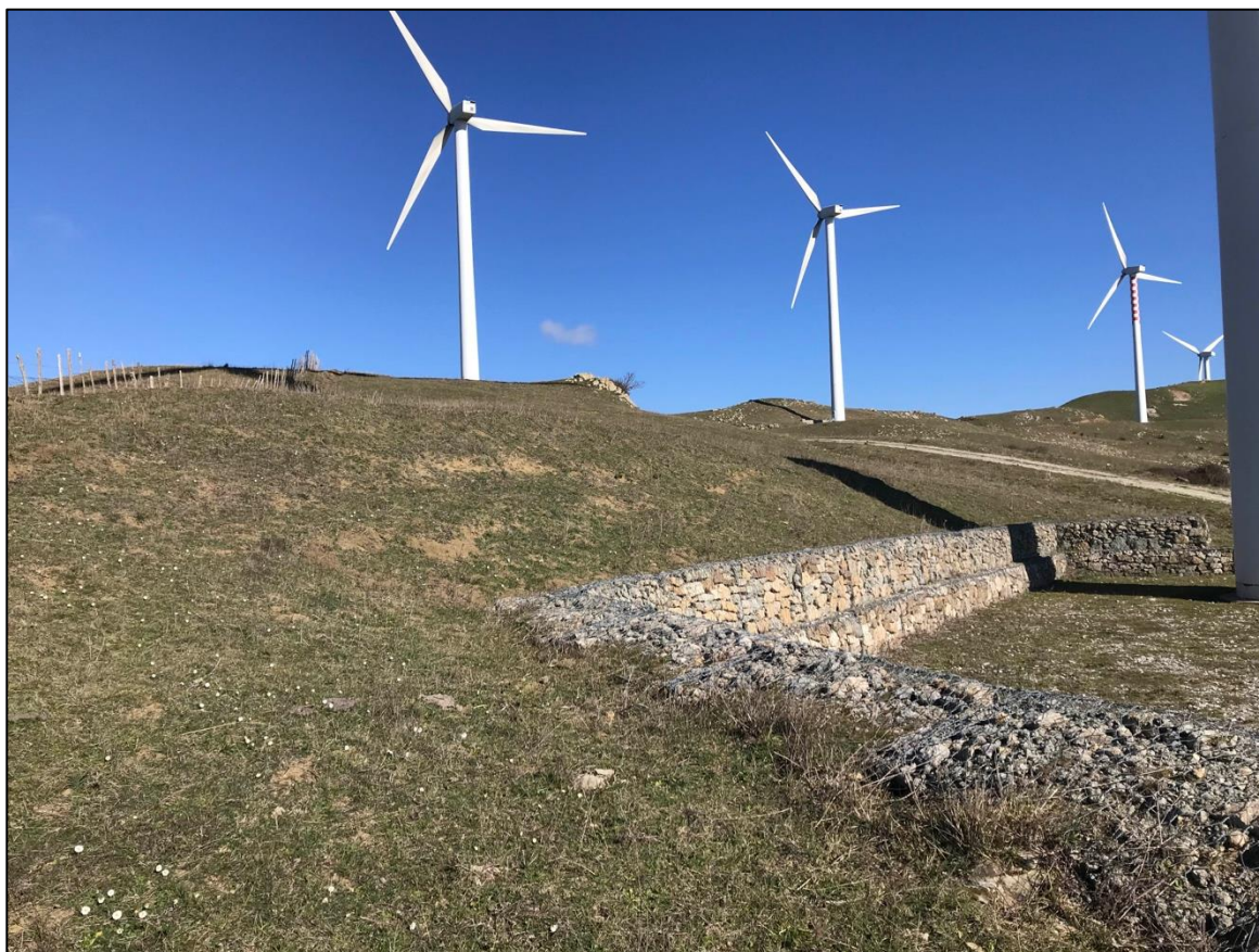
Foto 10 - Panoramica UR 03 (aerogeneratore NI02)
