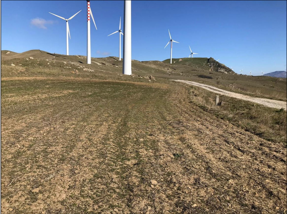
Foto 43 - Panoramica UR 12 (viabilità)
