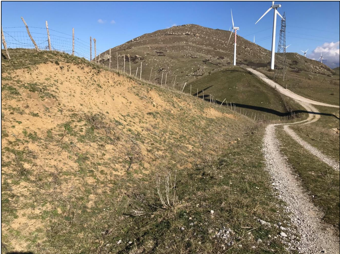
Foto 20 - Panoramica UR 04 (aerogeneratore NI03)
