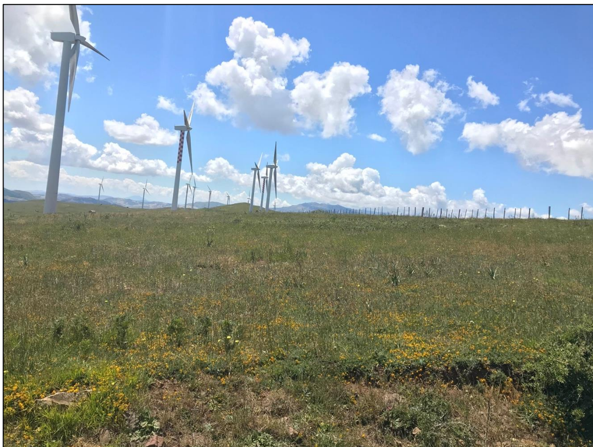
Foto 54 - Panoramica UR 17 (aerogeneratore NI09)
