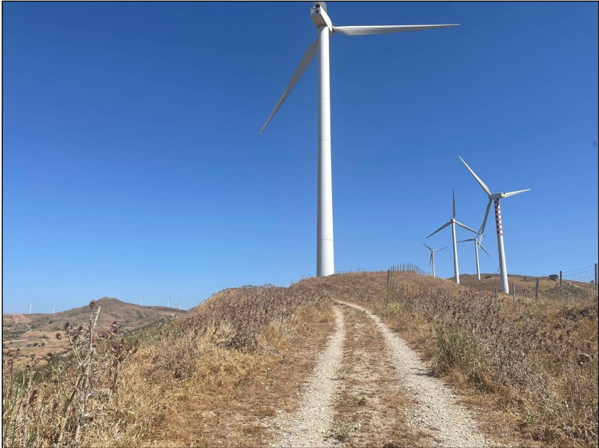
Foto 65 - Panoramica UR 21 (aerogeneratore NI12)
