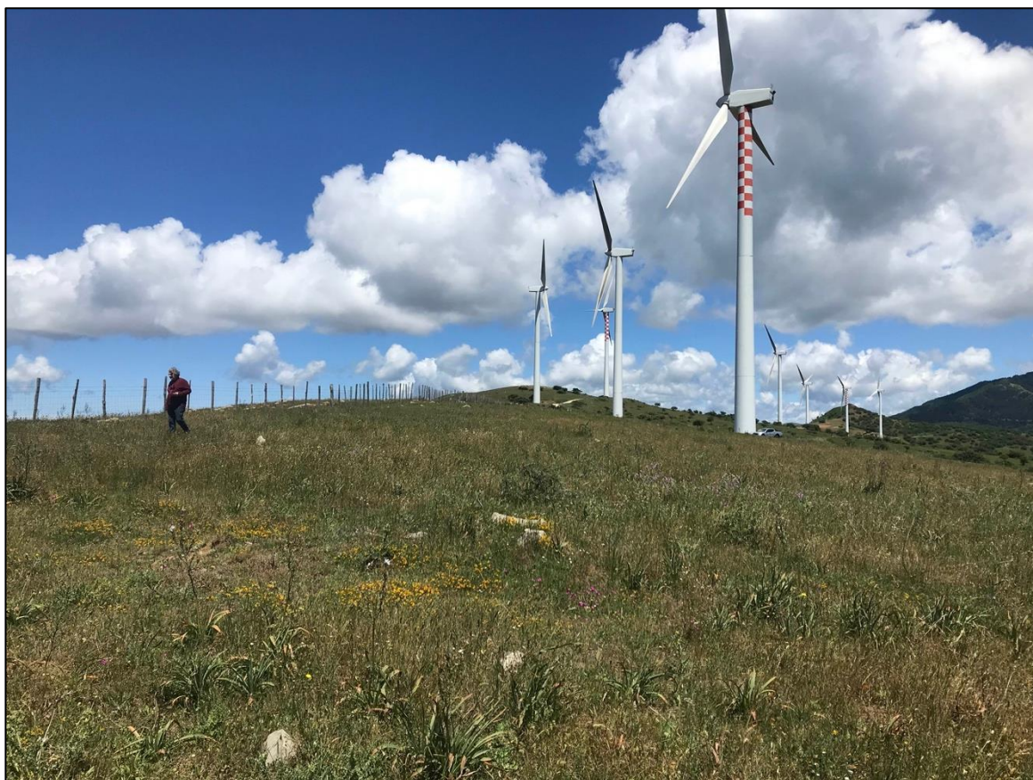
Foto 53 - Panoramica UR 17 (aerogeneratore NI09)
