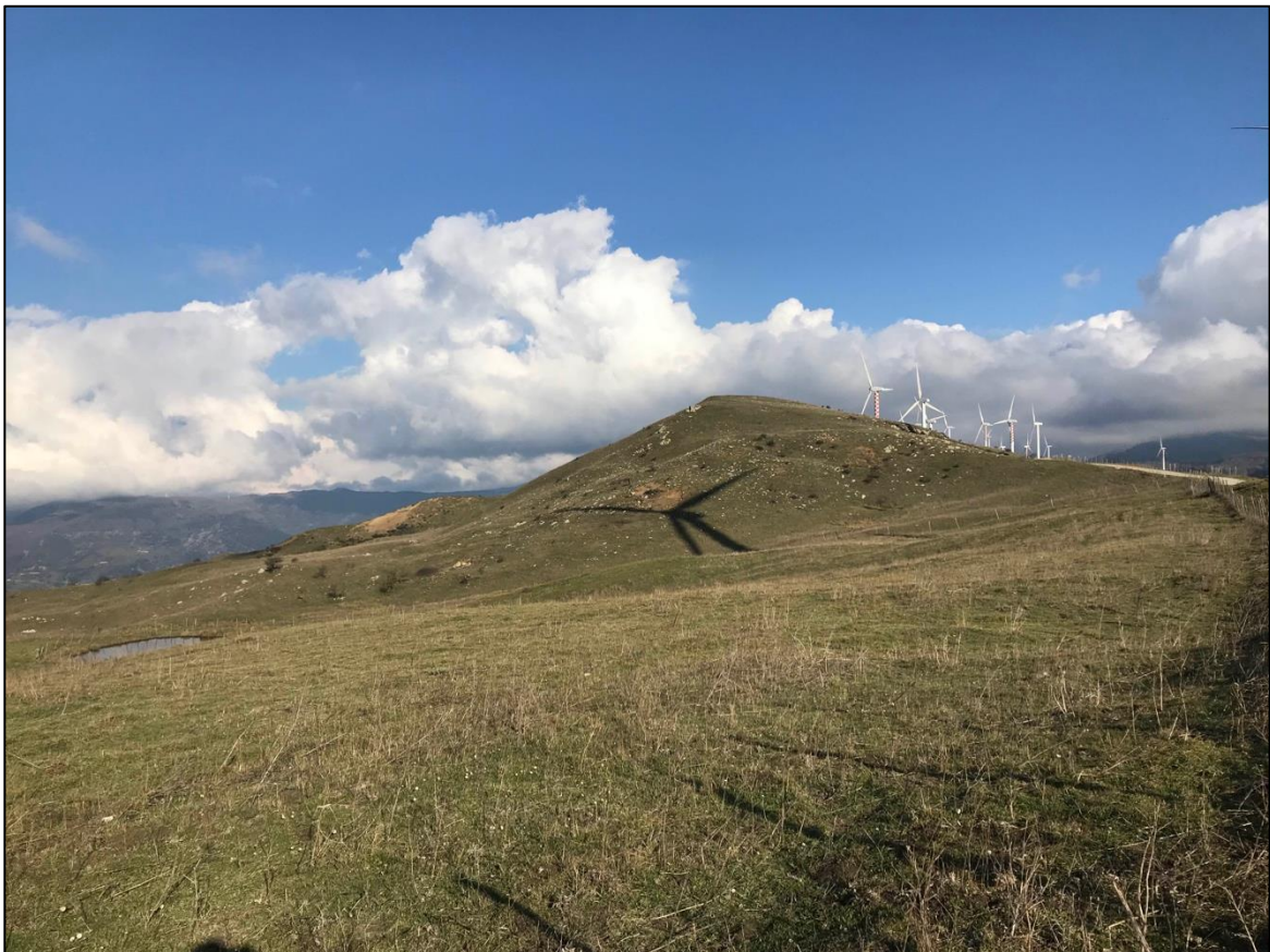
Foto 36 - Panoramica UR 09 (aerogeneratore NI07)
