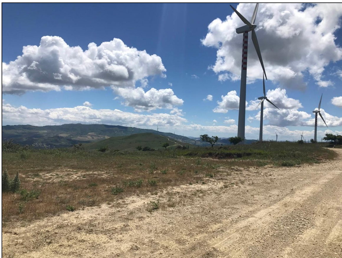
Foto 55 - Panoramica UR 18 (viabilità)
