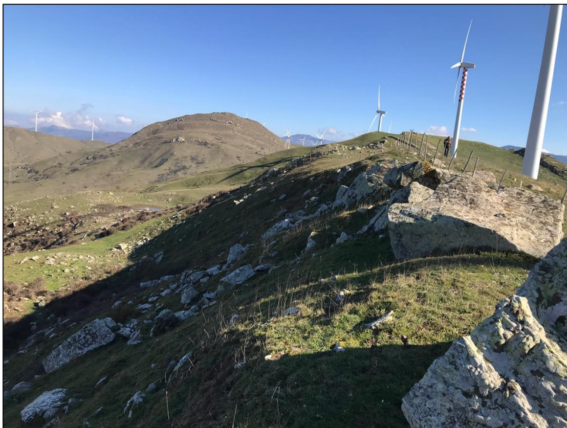
Foto 12 - Panoramica UR 03 (aerogeneratore NI02)
