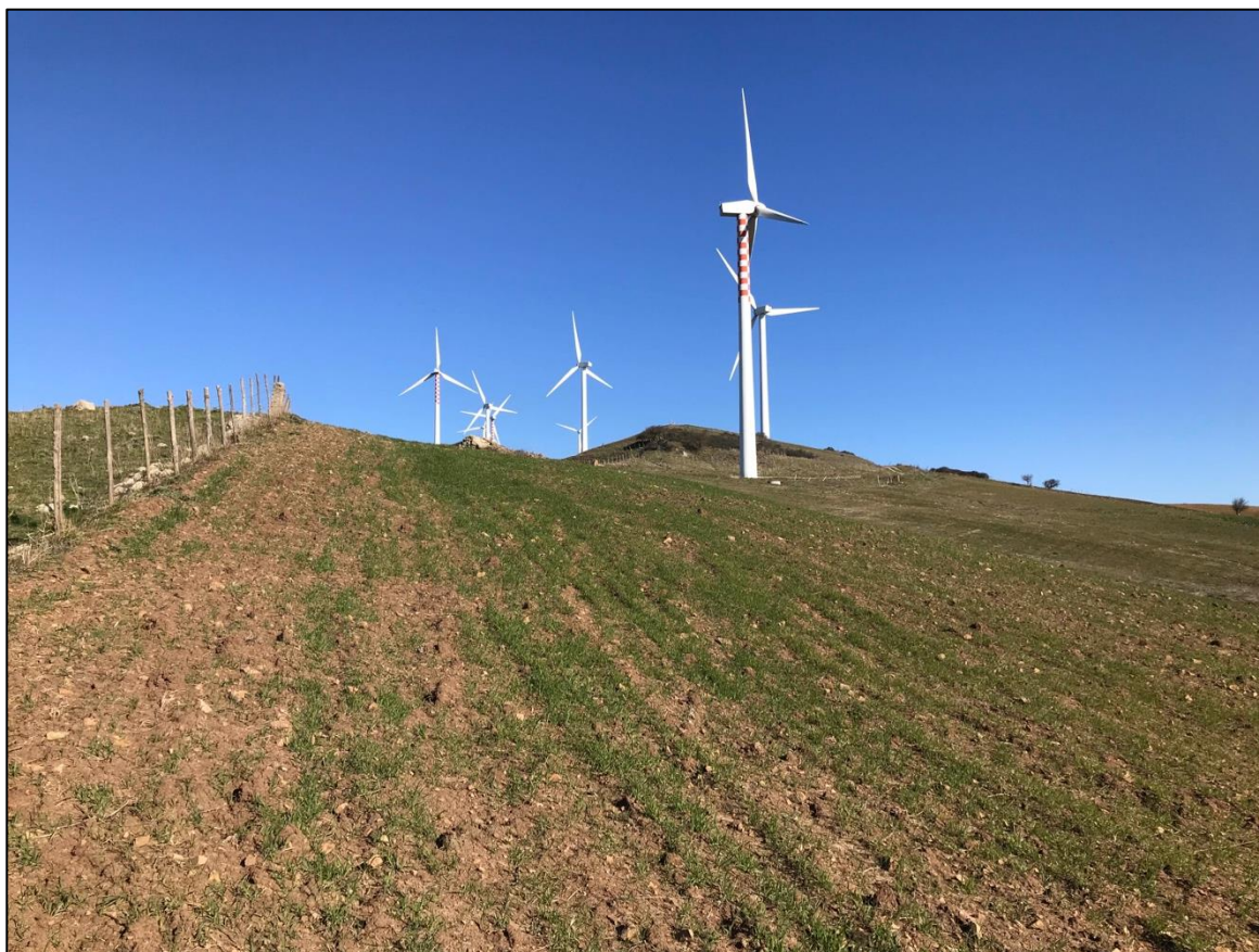
Foto 4 - Panoramica UR 01 (aerogeneratore NI01)
