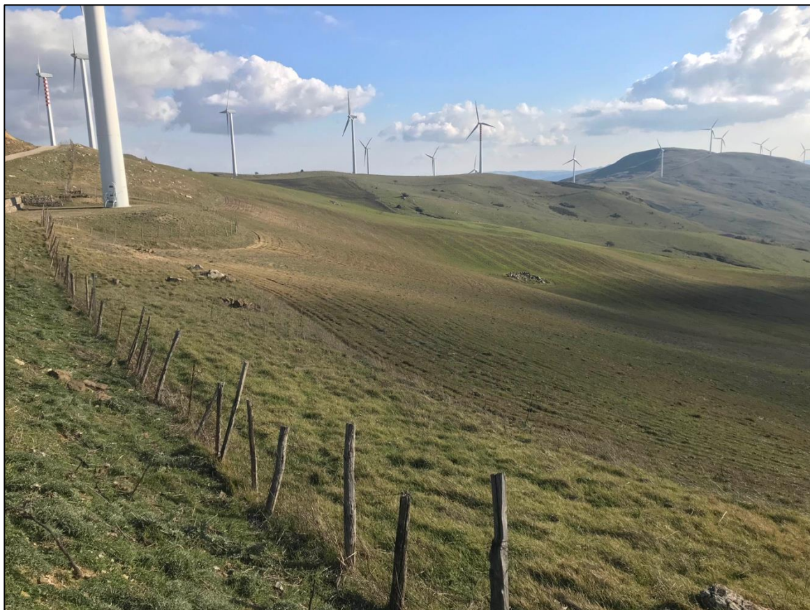
Foto 29 - Panoramica UR 08 (aerogeneratore NI06)
