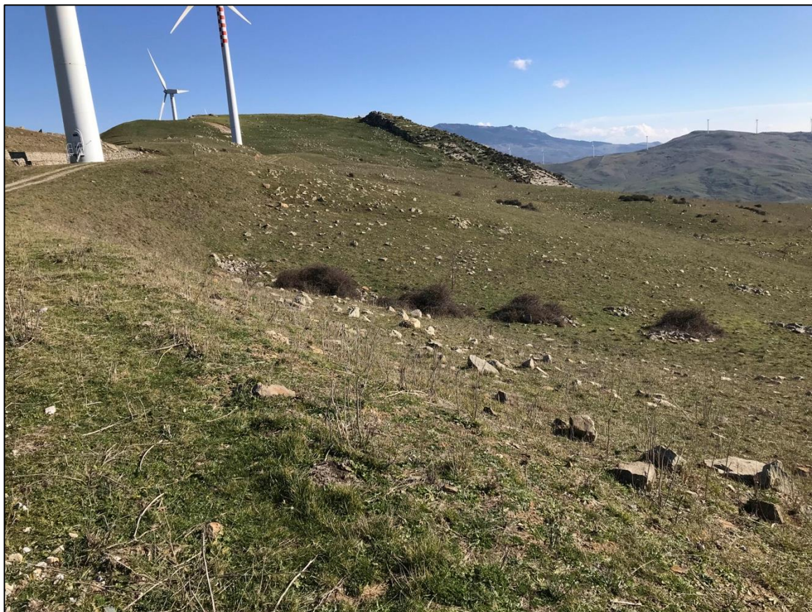
Foto 11 - Panoramica UR 03 (aerogeneratore NI02)
