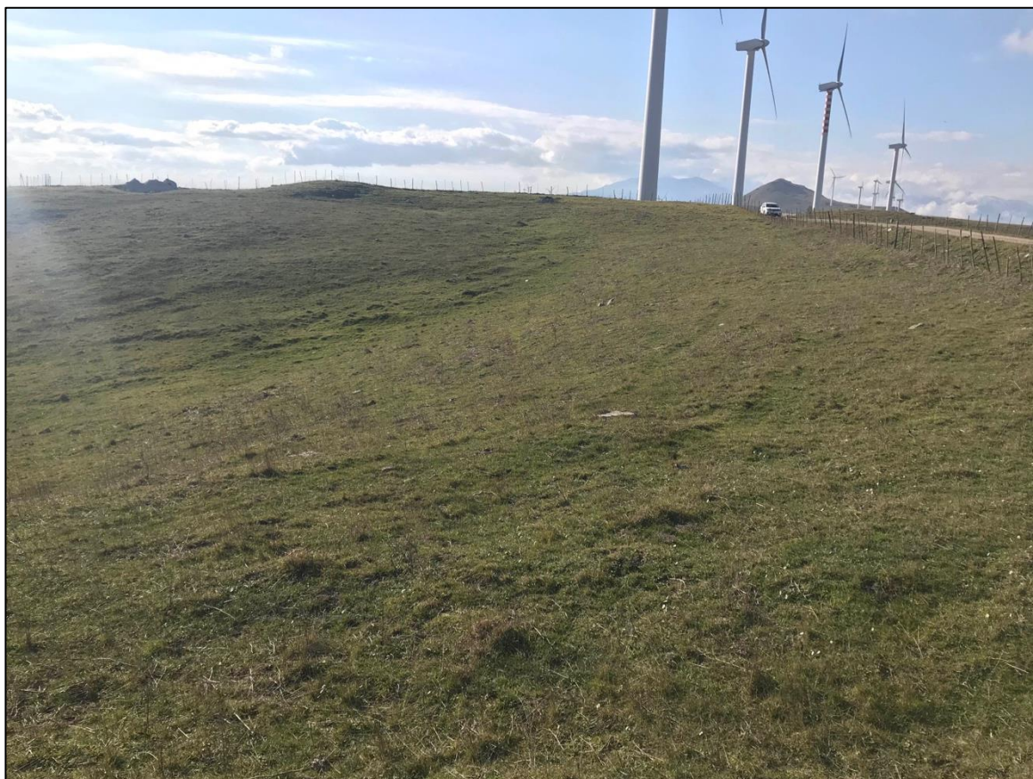
Foto 34 - Panoramica UR 09 (aerogeneratore NI07)
