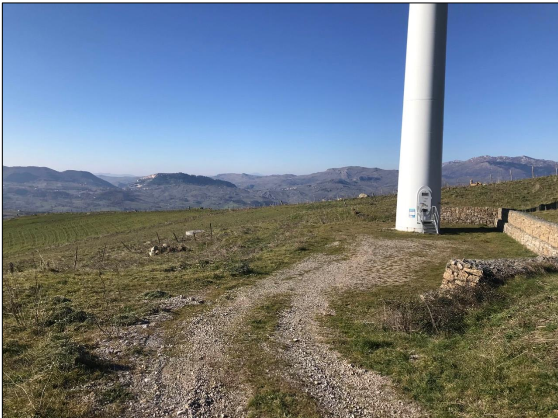
Foto 2 - Panoramica UR 01 (aerogeneratore NI01)
