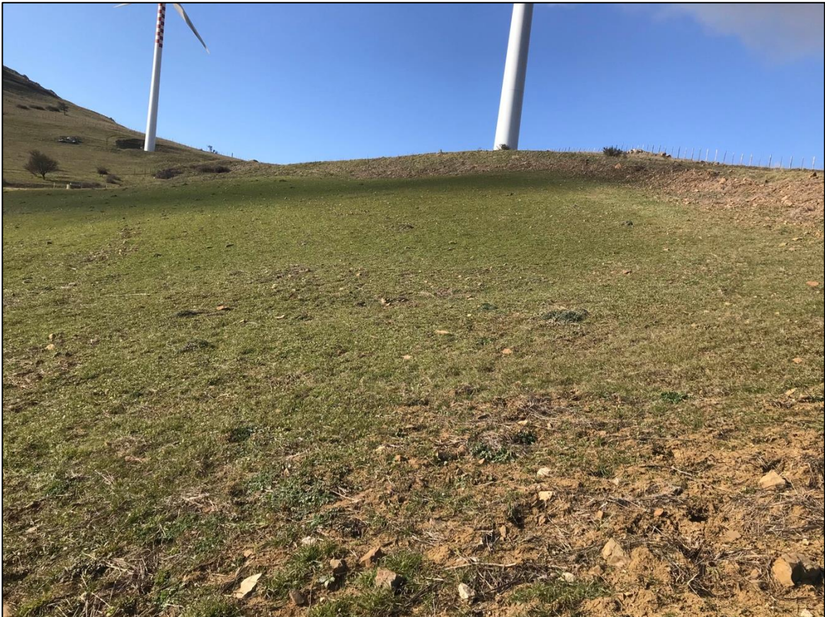
Foto 22 - Panoramica UR 06 (aerogeneratore NI04)
