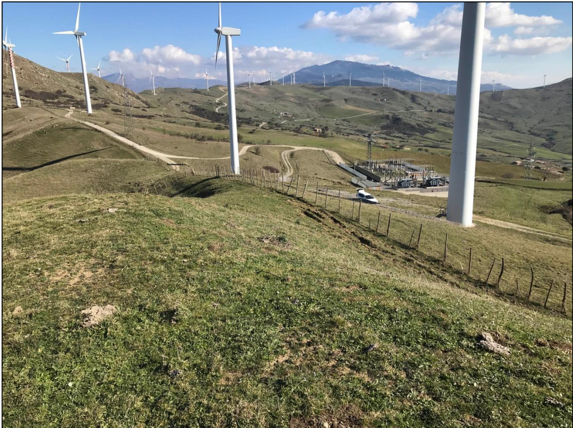
Foto 18 - Panoramica UR 04 (aerogeneratore NI03)
