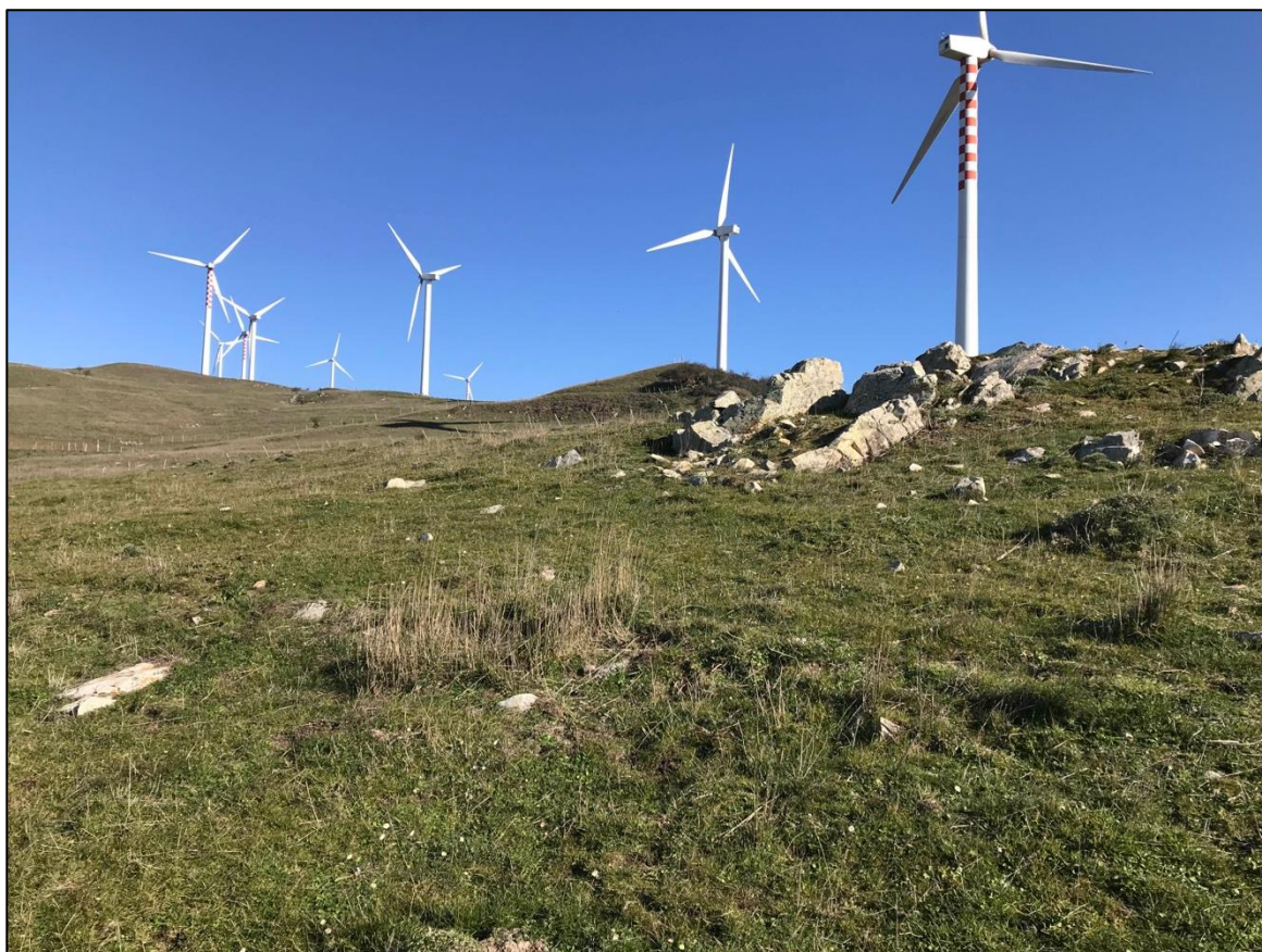
Foto 9 - Panoramica UR 02 (aerogeneratore NI01)
