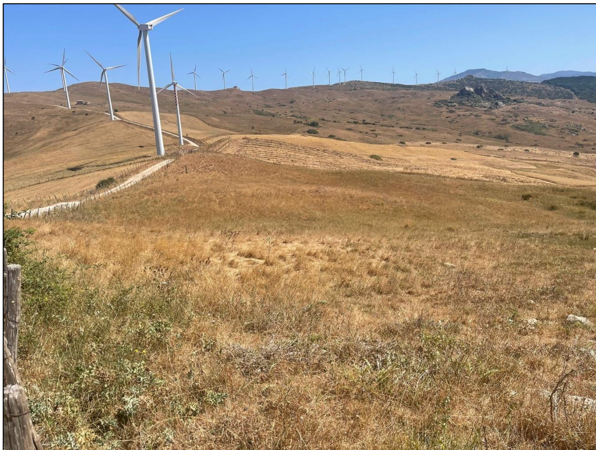
Foto 39 - Panoramica UR 10 (aerogeneratore NI13)
