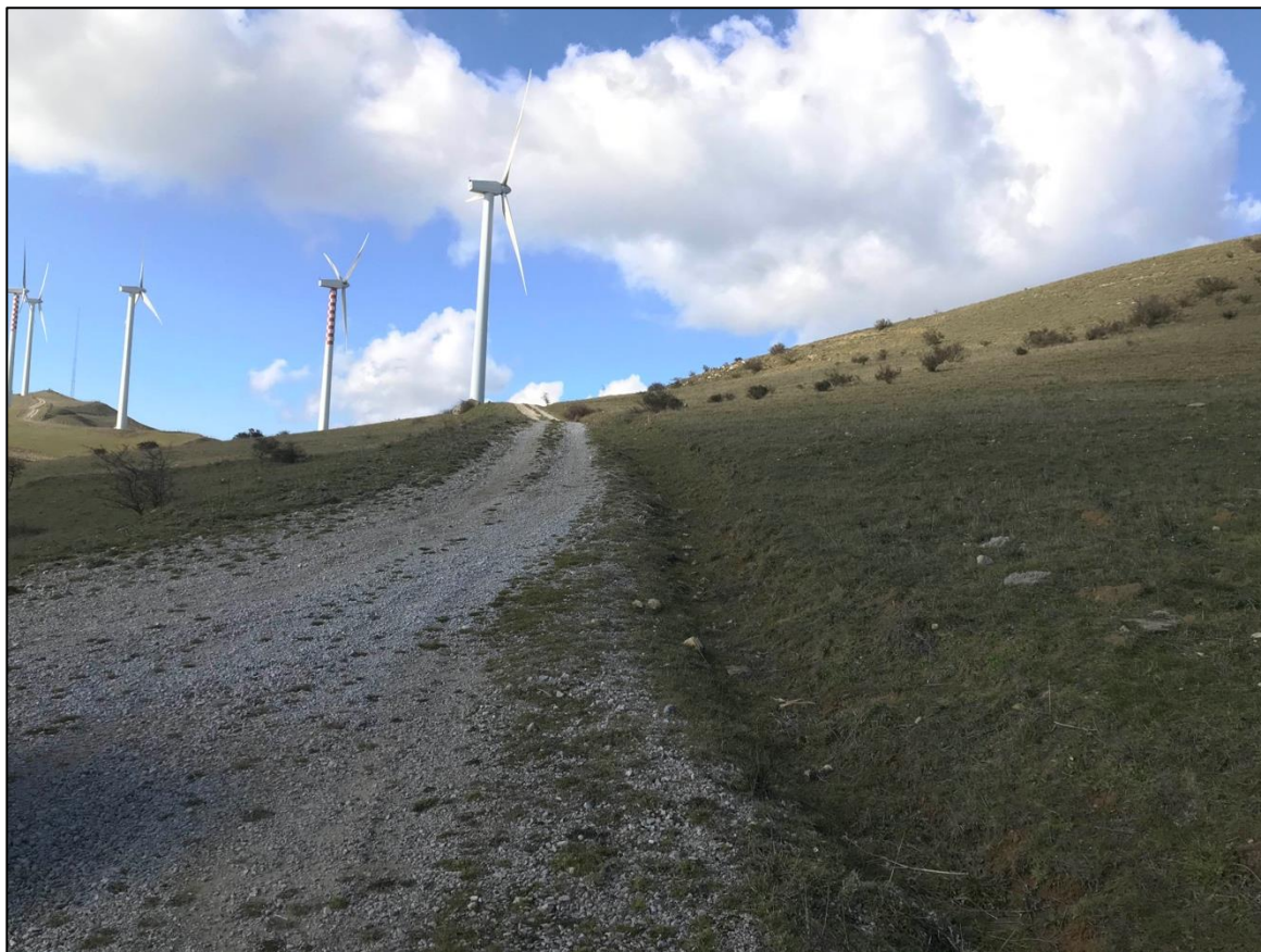
Foto 25 - Panoramica UR 07 (aerogeneratore NI05)
