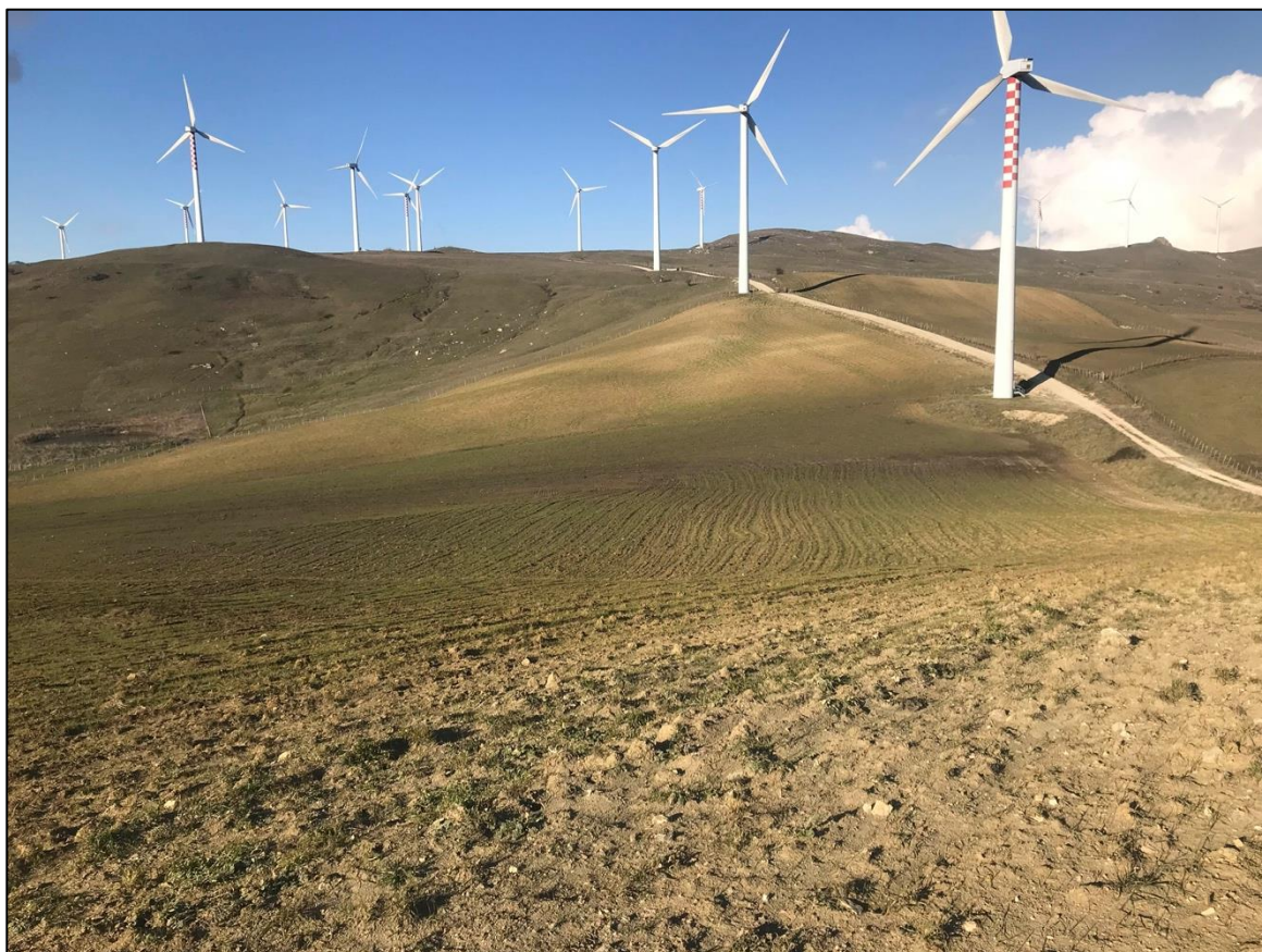
Foto 48 - Panoramica UR 15 (viabilità)
