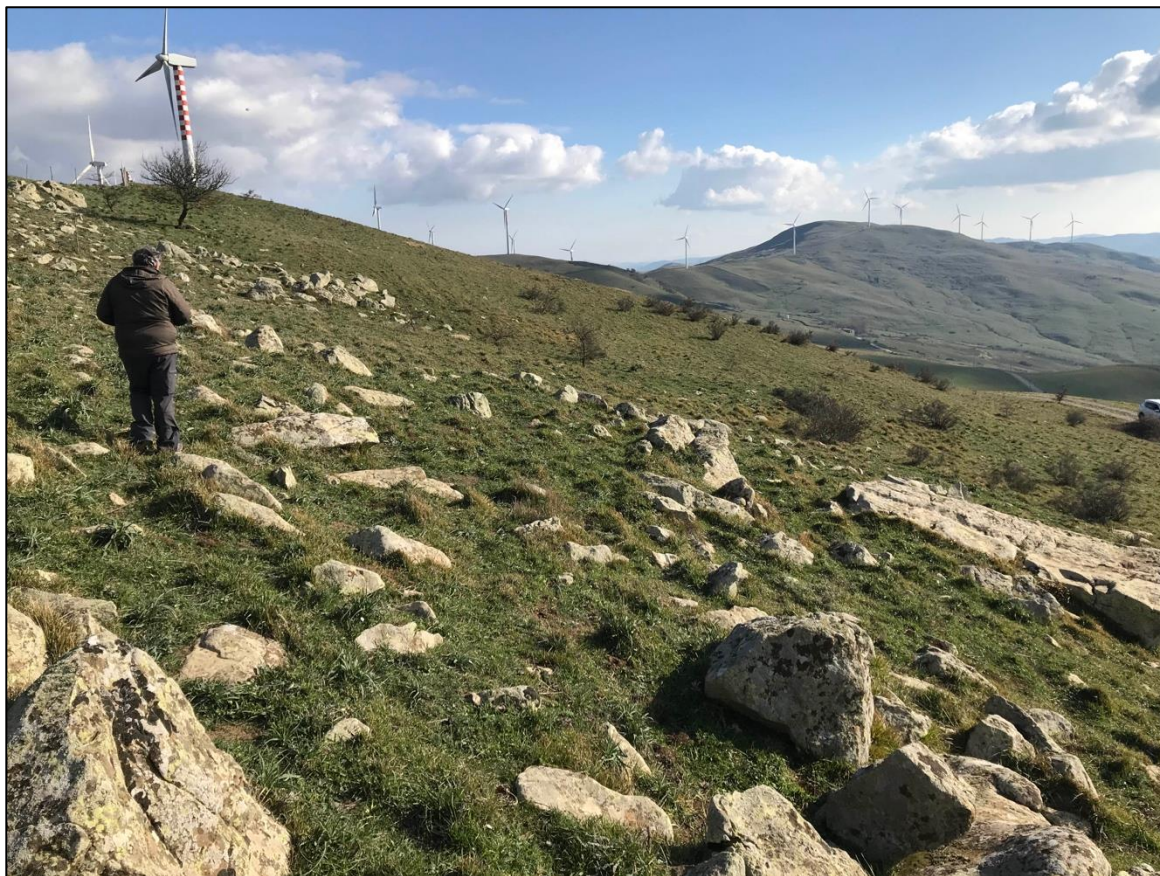
Foto 27 - Panoramica UR 07 (aerogeneratore NI05)
