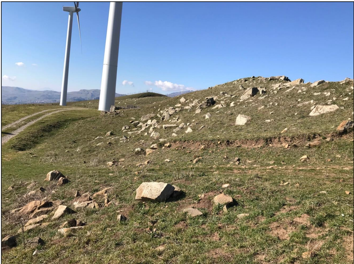
Foto 14 - Panoramica UR 03 (aerogeneratore NI02)
