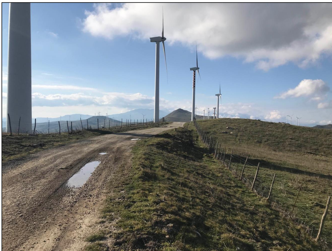
Foto 32 - Panoramica UR 09 (aerogeneratore NI07)
