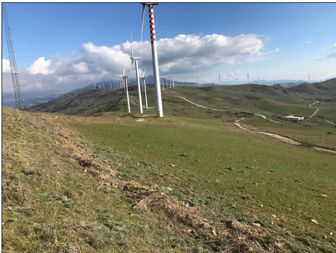
Foto 24 - Panoramica UR 06 (aerogeneratore NI04)
