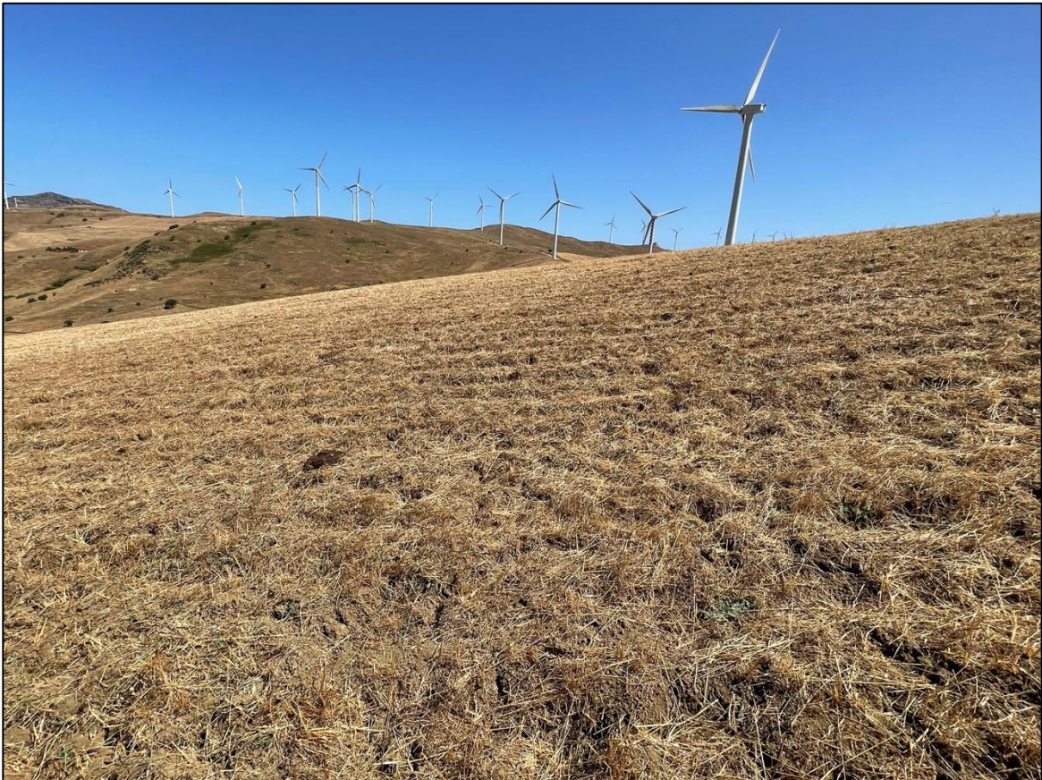
Foto 38 - Panoramica UR 10 (aerogeneratore NI13)
