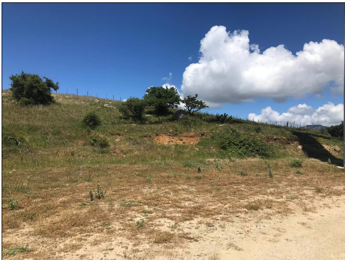
Foto 56 - Panoramica UR 18 (aerogeneratore NI10)
