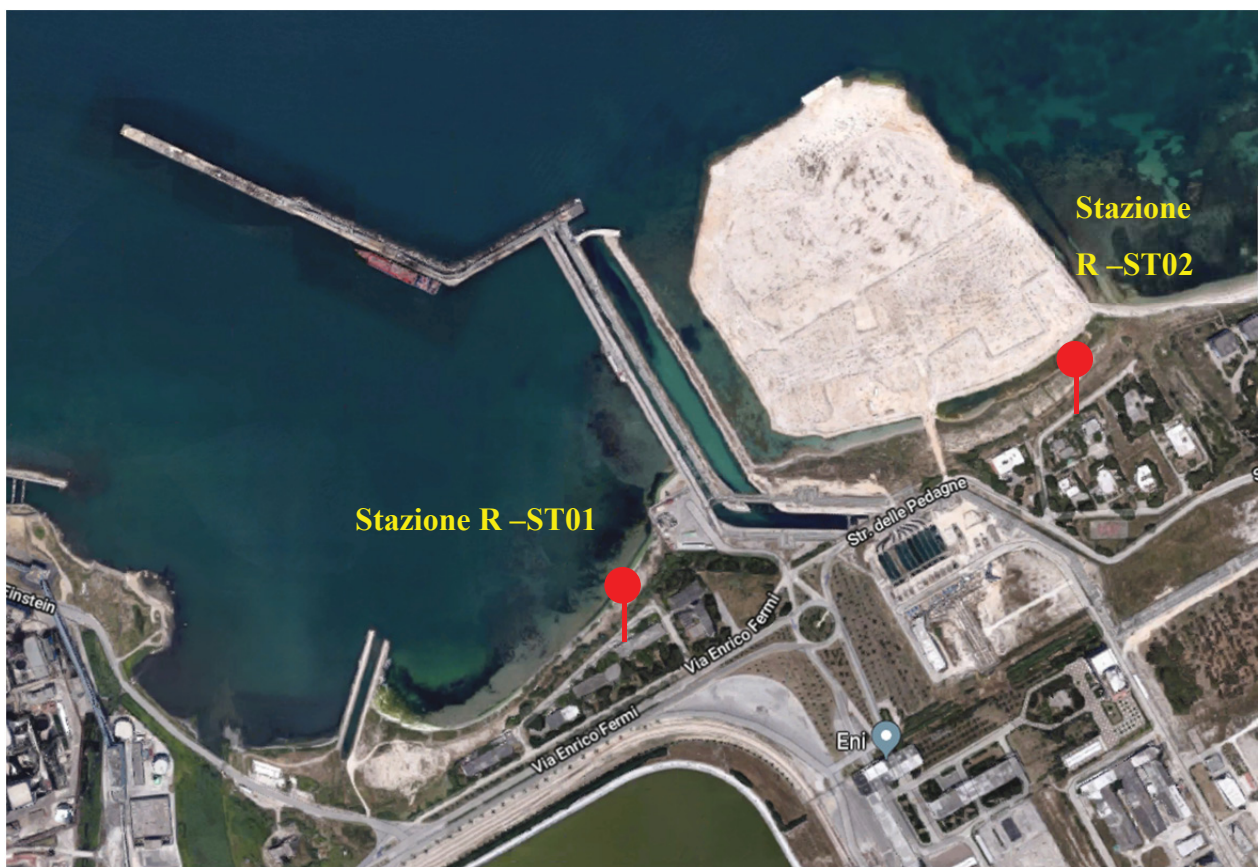
Figura 4 Stazione di misura per il monitoraggio acustico
