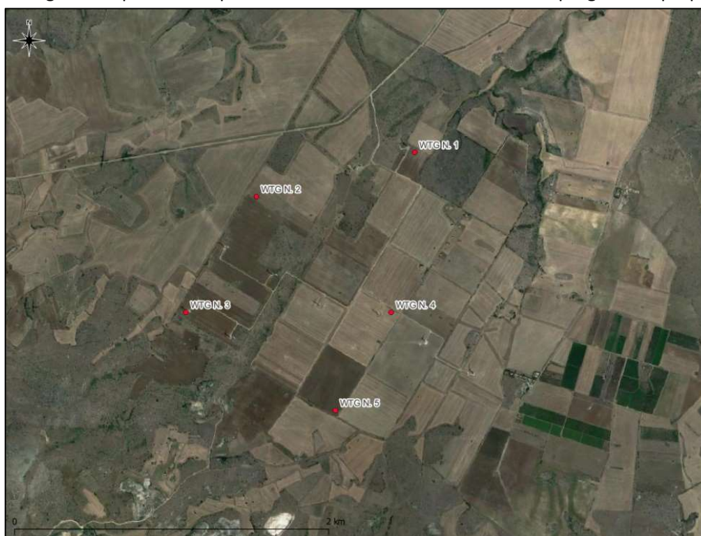
Impianto eolico di Minervino Murge attualmente in esercizio
