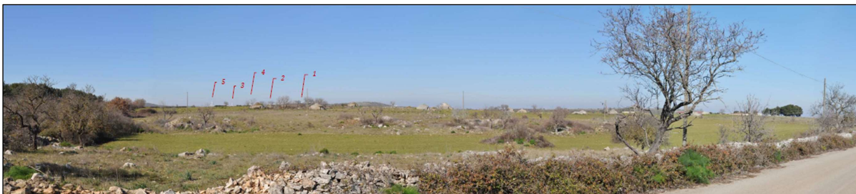
Stato Post operam dal punto di vista della Masseria "Finizio Tannoia"
