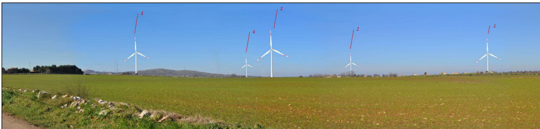
Stato Post operam dal punto di vista della Masseria "Sardaroni"
