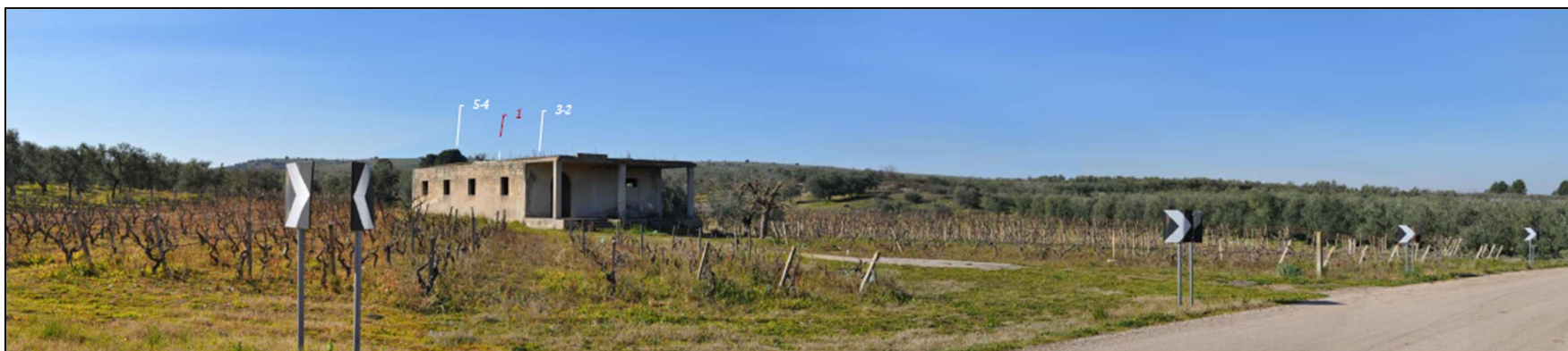
Stato Post operam dal punto di vista della Masseria "Sperlongana"
