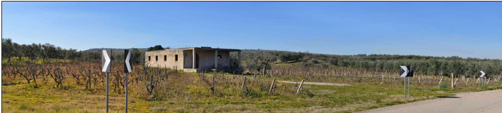
Stato Ante operam dal punto di vista della Masseria "Sperlongana"
