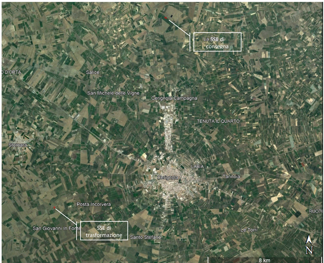
Fig. 1.1 – Inquadramento su immagine satellitare Google Heart dell'area vasta in cui ricadono i siti di intervento
