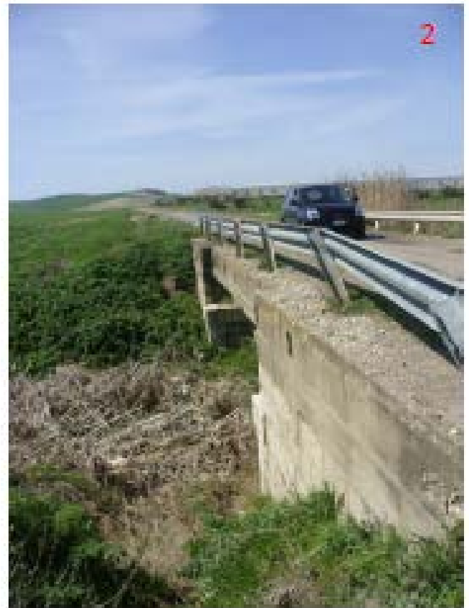
Fig. 6 – foto dell'esistente ponte in calcestruzzo col quale interferisce il cavidotto in AT sotto la SP 79.
