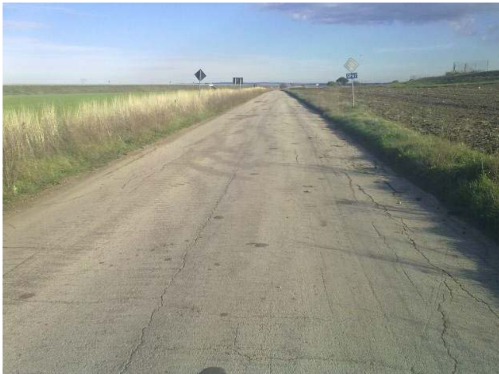
Fig. 15 – Foto Tratturo Melfi-Castellaneta percorso longitudinalmente dal cavidotto
