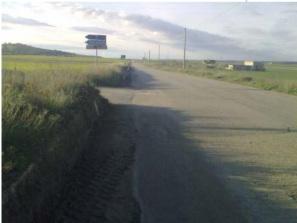
Fig. 16 – Foto Tratturo Comunale Al Piano percorso longitudinalmente dal cavidotto
