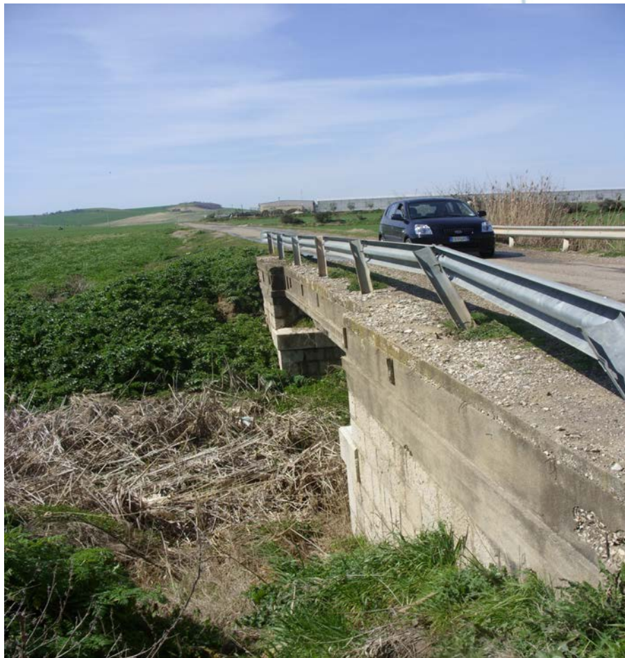
Fig. 18 – Foto del ponte in cls sulla SP 79 in corrispondenza dell'asta pubblica n. 416
