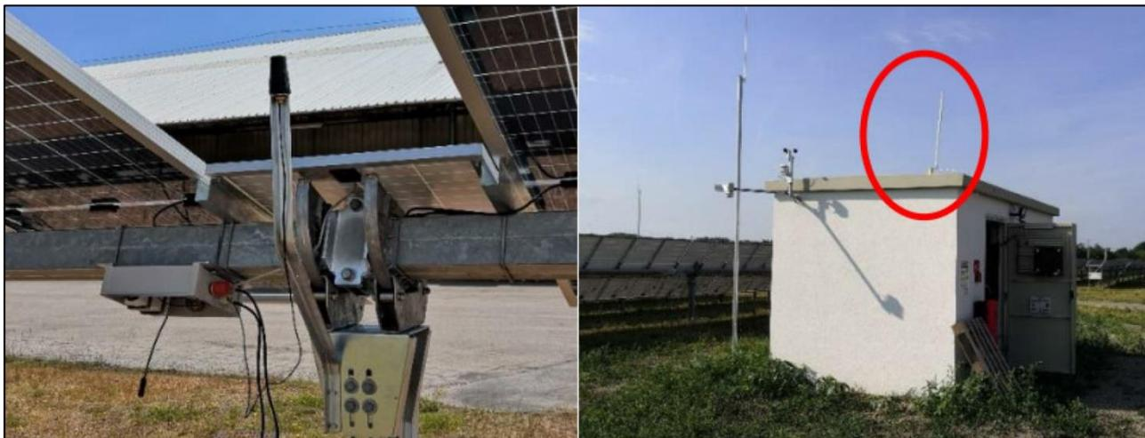
*Figura 3.10: Esempio di collegamento - L'antenna TP sul tracker (a sinistra) e l'antenna del RP nella parte superiore della stazione di trasformazione (a destra).*
